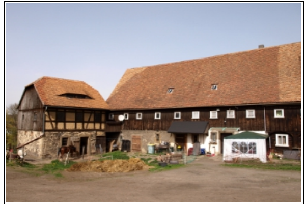
Ansicht der denkmalgeschützten Gebäude: Seitengebäude und Wohnstallhaus aus Richtung Südwest
