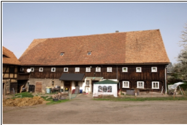
Ansicht des denkmalgeschützten Wohnstallhaus aus Richtung Südwest
