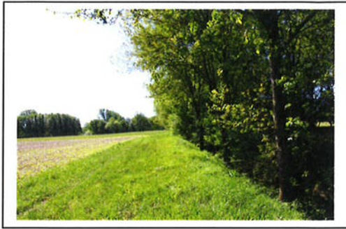
Teilansicht; Fließgewässer, Ufer-/Wasserbereich des Flurstückes Nr. 169.
