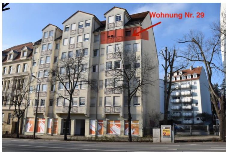
Foto 1: Ostansicht des Gebäudes mit Markierung der Wohnungslage
