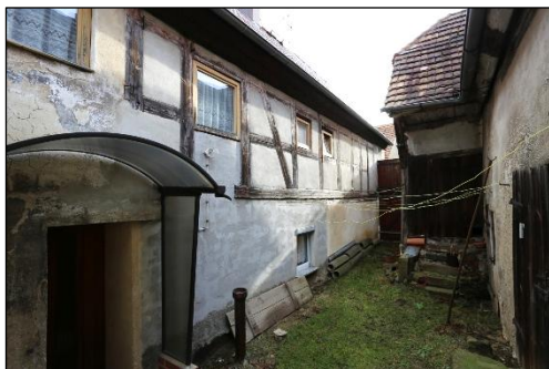
Gebäuderückseite in Richtung Scheune
