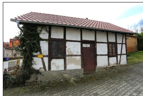
Blick auf das separate Lagergebäude
