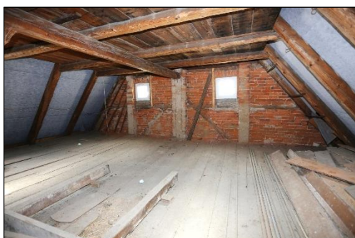
Blick auf den Dachboden
