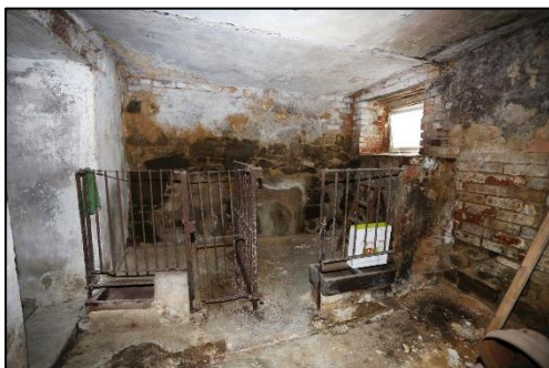
Der Stall befindet sich noch in seinem Ursprungszustand
