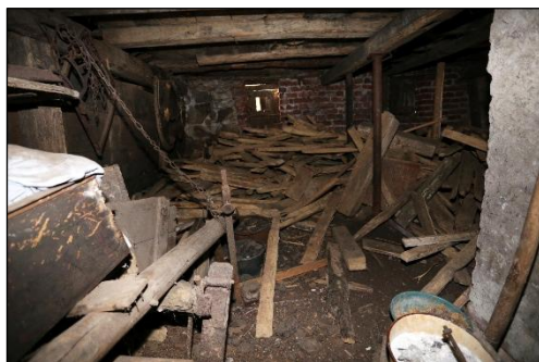
Blick in einen Lagerraum der Scheune
