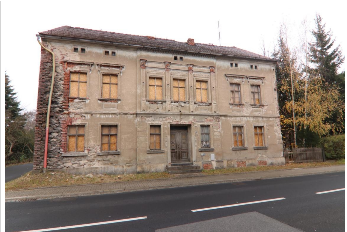
Blick auf die westliche Straßenfassade des zu bewertenden ehemaligen Wohn- und Geschäftshauses Görlitzer Straße 10 in Zittau OT Hirschfelde.
