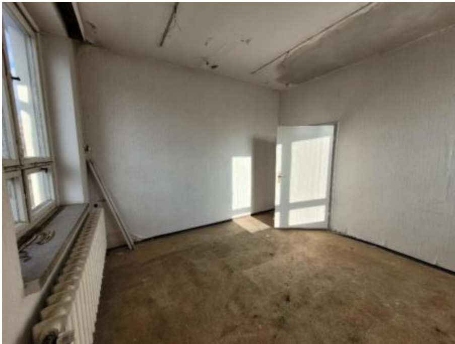
Raum im Obergeschoss
