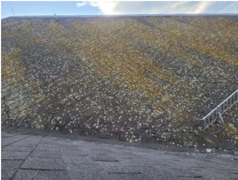
Blick auf die Dacheindeckung
