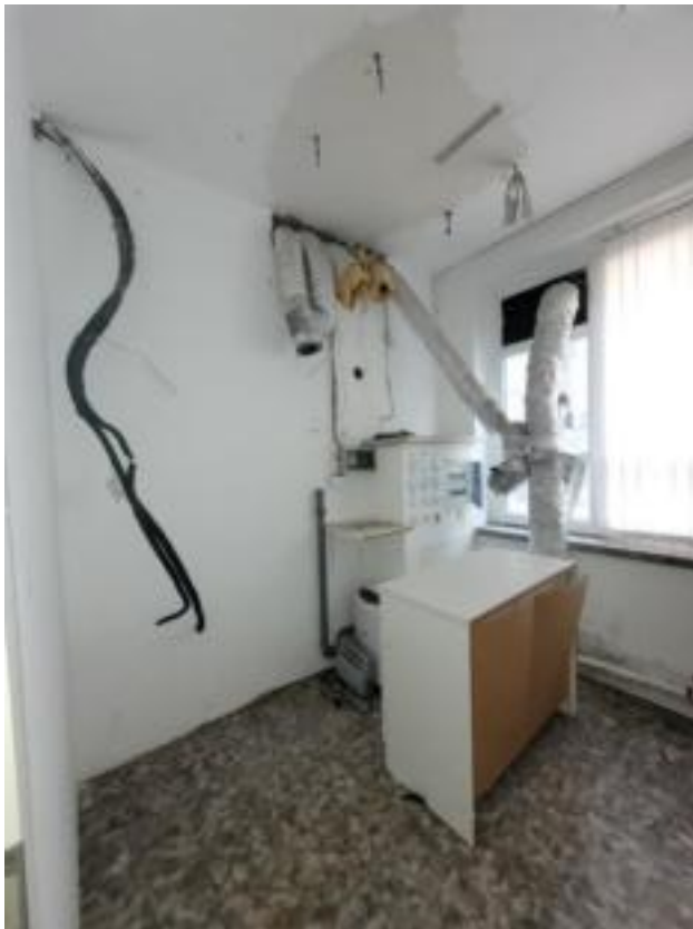
Raum der von der Humboldtstraße aus zugänglichen Gewerbeeinheit (ehemalige „Salzgrotte“)
