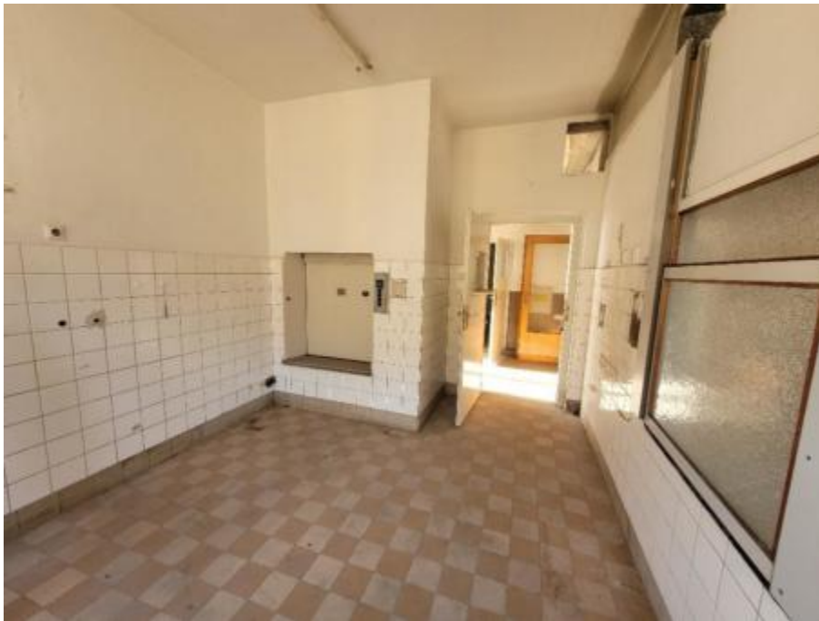
Küche im Obergeschoss
