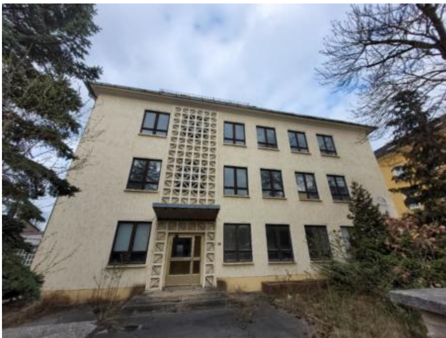
Blick auf den Haupteingangsbereich; zur Solbrigstraße orientiert
