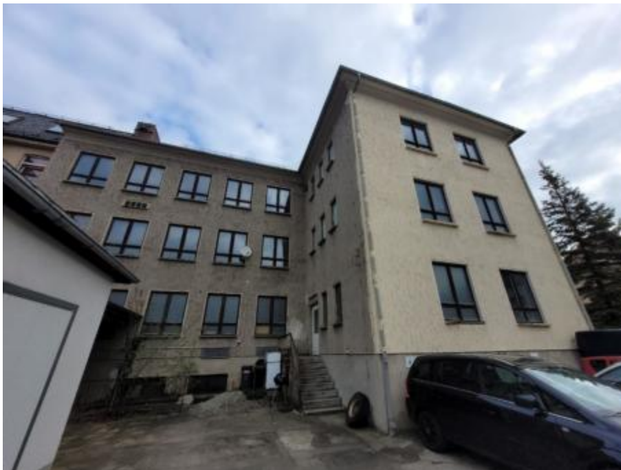
Blick auf die hofseitige Fassade
