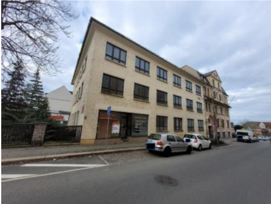
Blick auf den zur Humboldtstraße orientierten Fassadenbereich
