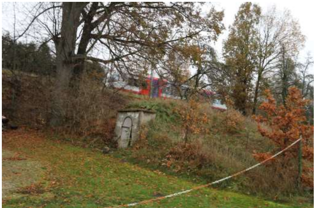
Blick zum Bahndamm
