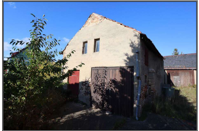
Süd-Ost-Ansicht der Schuppen
