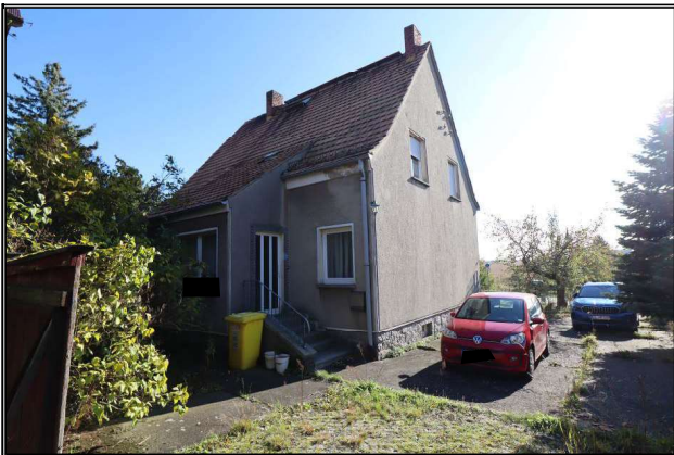
Nord-West-Ansicht des Wohnhauses mit Eingangsbereich
