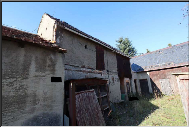
Süd-Ost-Ansicht der Schuppen
