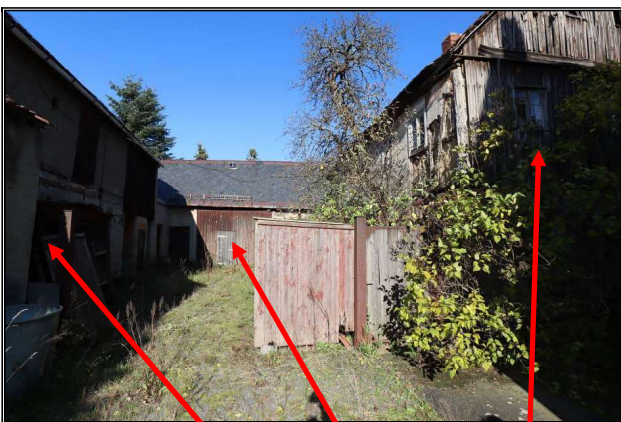
Hofbereich mit Schuppen, Scheune und Fachwerkhaus
