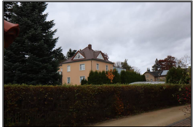
Süd-Ost-Ansicht des Wohnhauses mit Praxis im EG
