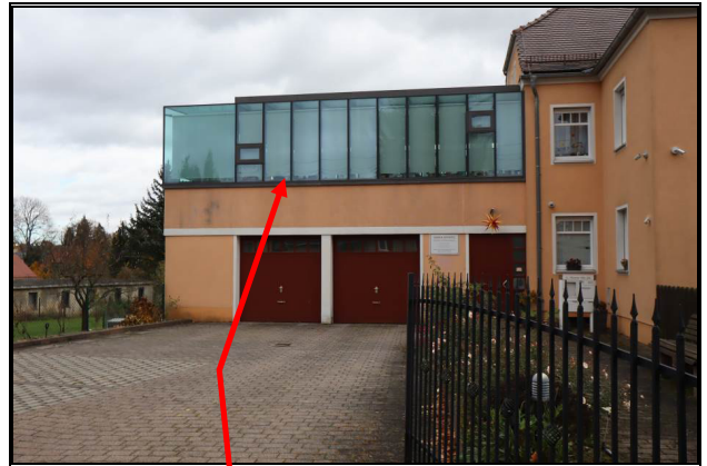
Detailansicht des Garagenanbaus mit aufgelagertem Wintergarten der ETW 2
