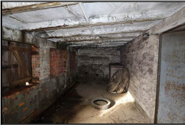
Raum im Erdgeschoss
