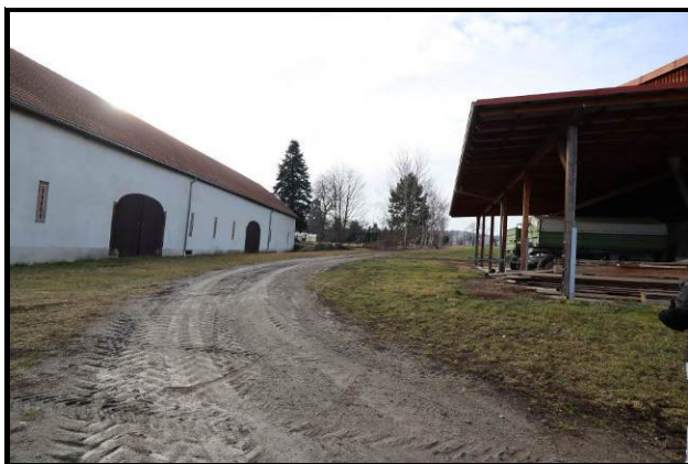
Grundstückszuwegung über Fremdfurstück 10/12
