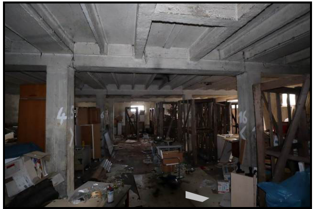
Raum im Erdgeschoss
