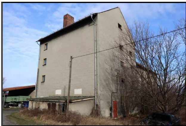
Süd-Ost-Ansicht des Bewertungsobjekts
