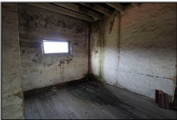
Raum im Obergeschoss
