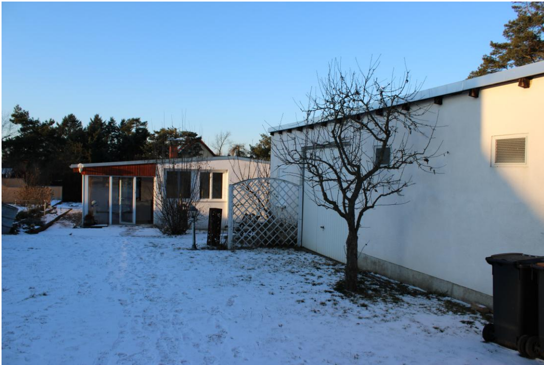
Foto Nr. 1: Ansicht Ostseite (Straßenseite)
