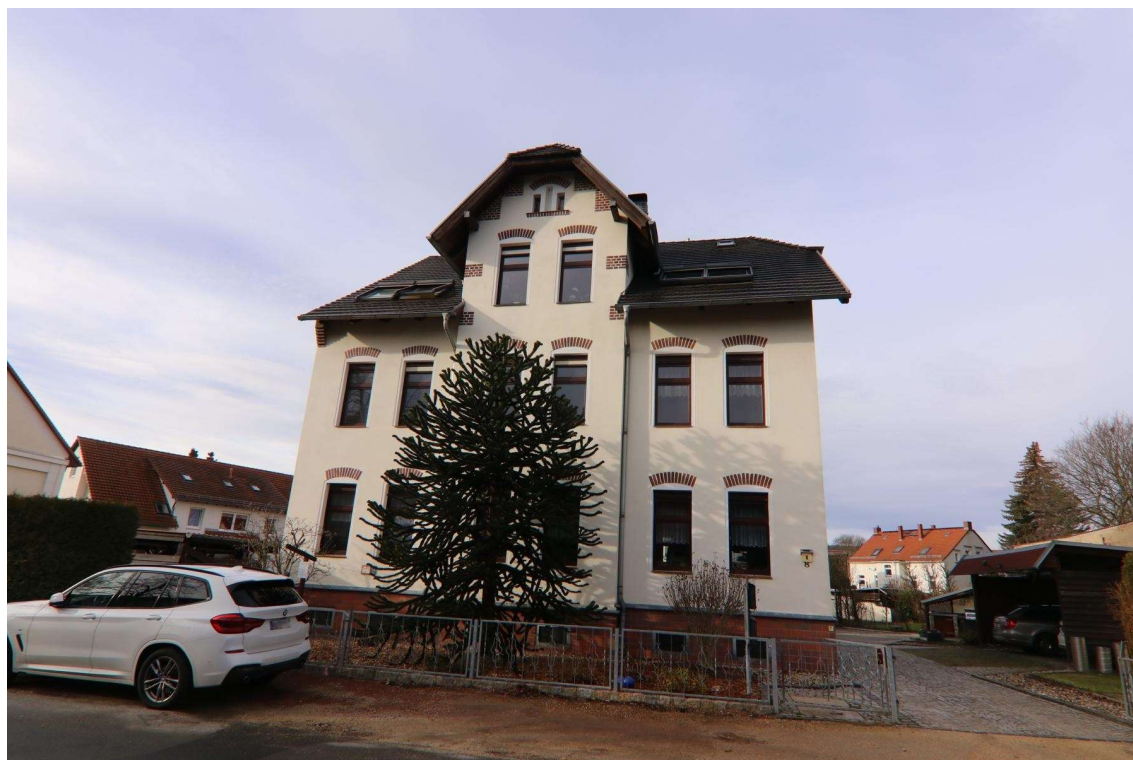
Blick in westliche Richtung auf die Straßenfassade des zu bewertenden Mehrfamilienhauses Rosa-Luxemburg-Straße 8 in Görlitz.
