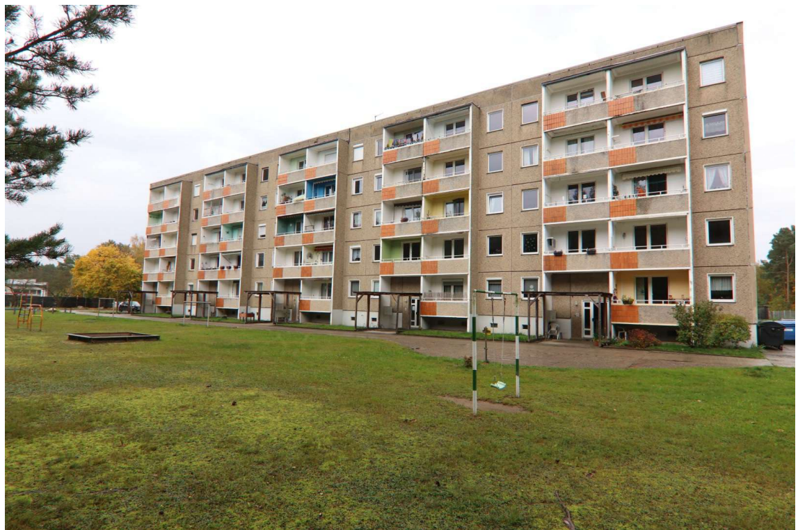
Blick in östliche Richtung auf die westliche Längsseite des Mehrfamilienwohnhauses Trebuser Straße 15 - 19 in Rothenburg/O.L. OT Uhmansdorf, in dem sich die Wohnung W 3.08 befindet
