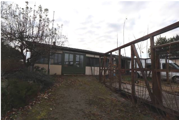
Nord-Ansicht des Werkstattgebäudes (Teilgrundstück 2)
