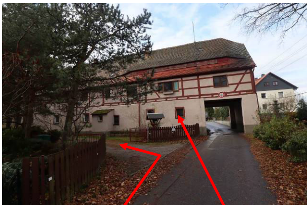
Zufahrt zum Teilgrundstück 1; denkmalgeschützter Gebäudeteil (Hausnr. 29)
