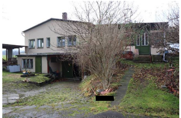
Nord-Ost-Ansicht des Werkstattgebäudes
