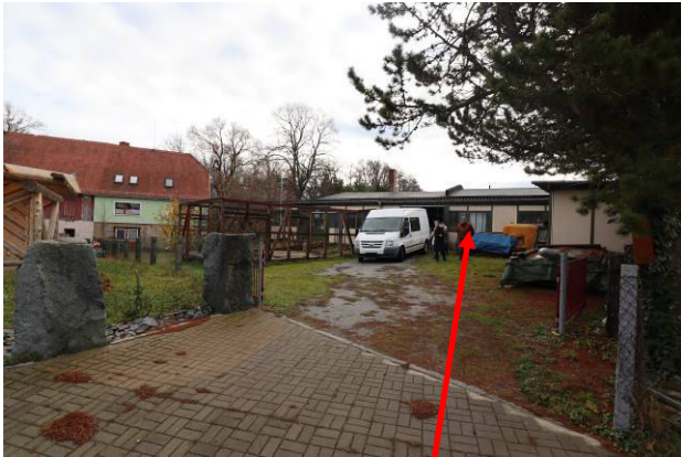
Blick zum Werkstattgebäude
