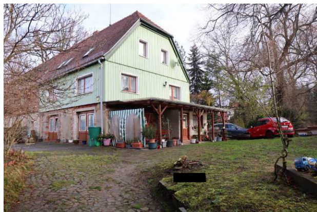
West-Ansicht des Wohnhauses
