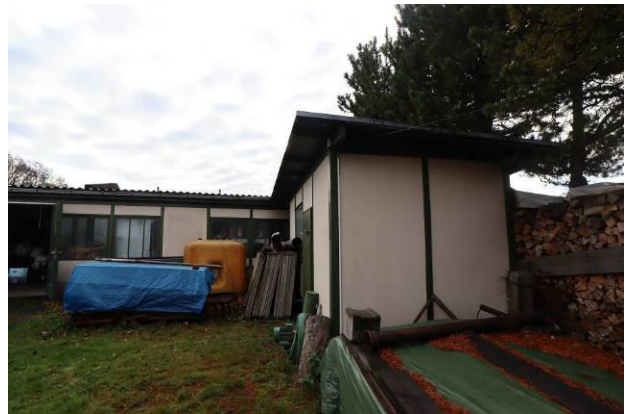
Spänebunker auf Teilgrundstück 1
