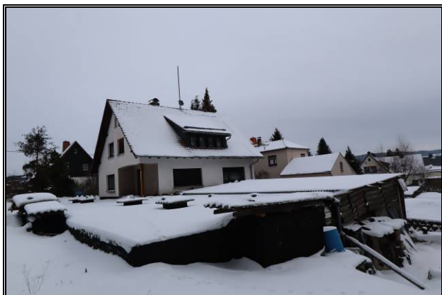
Süd-West-Ansicht des Wohnhauses sowie des angebauten Nebengebäudes – TG 1
