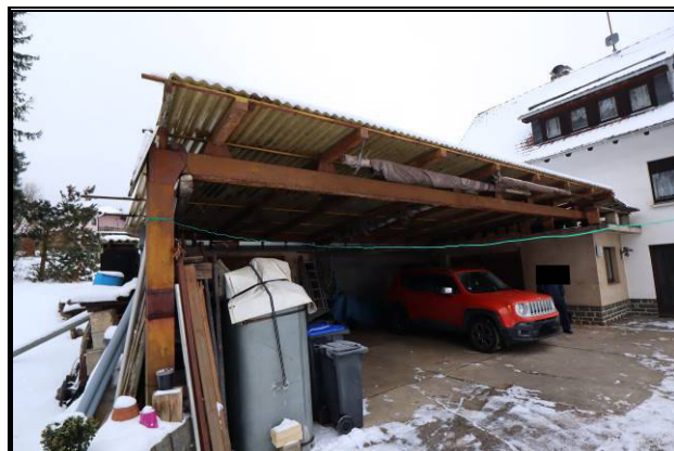
Detailansicht des Vordachs – TG 1
