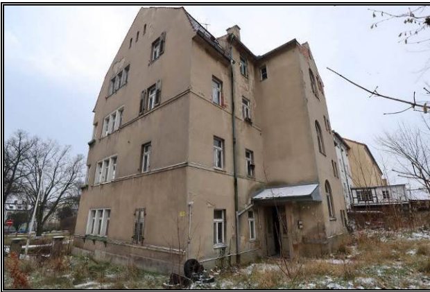
Nord-Ost-Ansicht des Bewertungsobjekts mit Eingangsbereich
