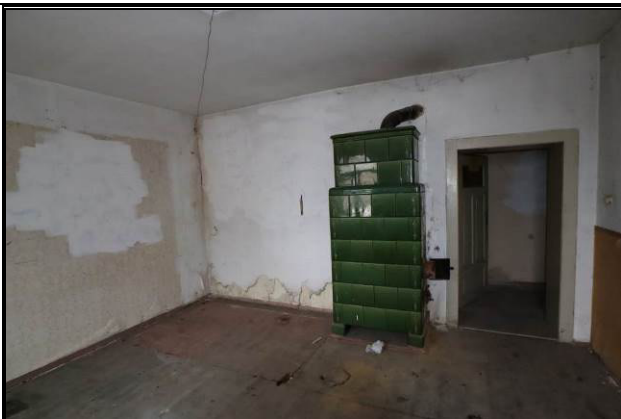
Ansicht eines Zimmers im EG
