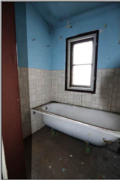
Bad im DG (Zugang über Treppenhaus)
