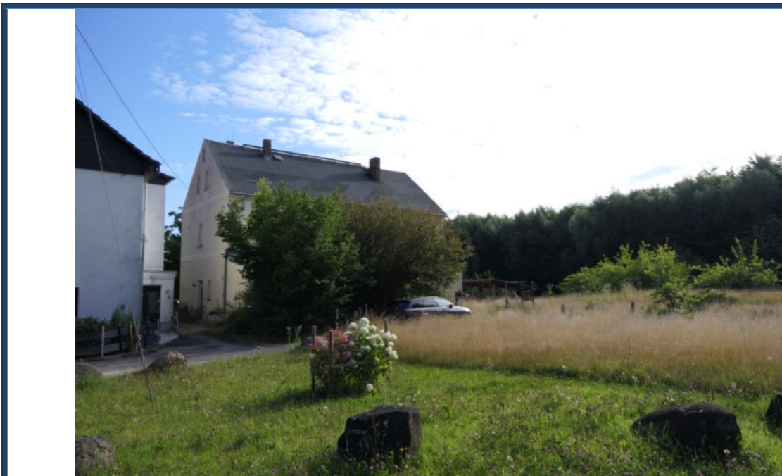
Abbildung 22: Einfahrtsbereich über das benachbarte Flurstück 446/b; verwilderte Außenanlagen; benachbarte Bebauung auf Flurstück 446/b und rechts das zu bewertende Wohngebäude
