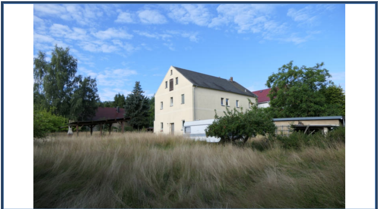
Abbildung 16: Blick vom westlichen Grundstücksbereich zum Wohngebäude; verwilderte Außenanlagen
