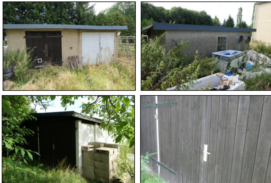
Abbildung 12: Nebengebäude (zwei massive Doppelgaragen) im nördlichen Grundstücksbereich; verwilderte Außenanlagen; tlw. Unratablagerungen
