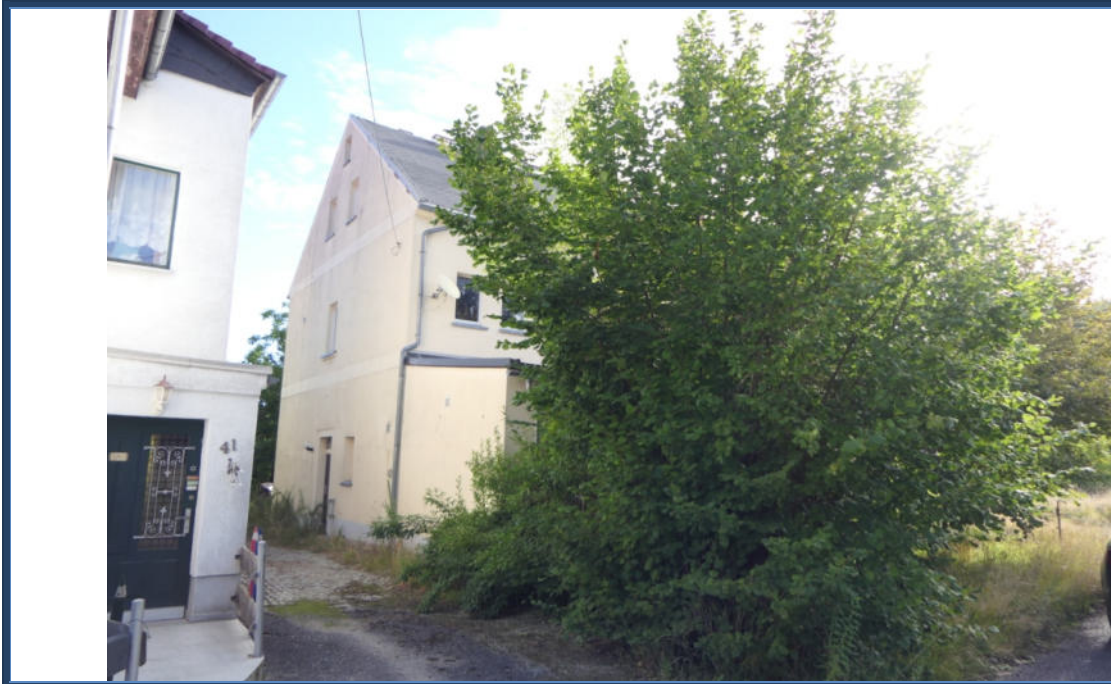
Abbildung 21: Einfahrtsbereich über das benachbarte Flurstück 446/b; verwilderte Außenanlagen; benachbarte Bebauung auf Flurstück 446/b und rechts das zu bewertende Wohngebäude
