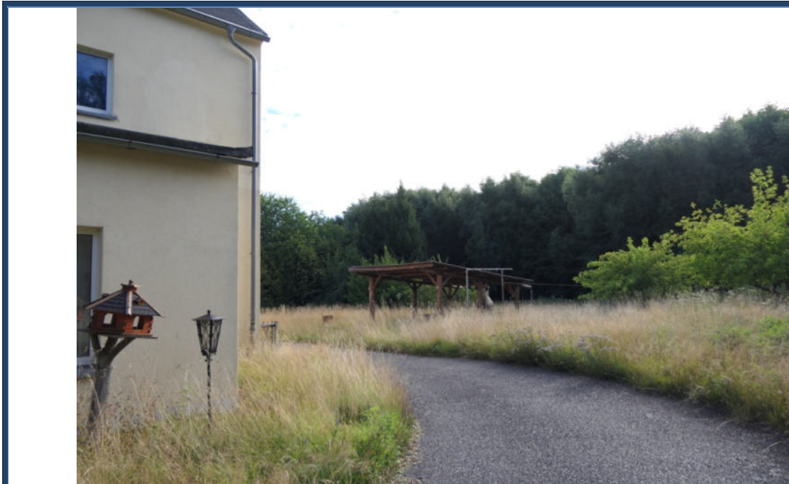
Abbildung 19: Einfahrtbereich; links das Wohngebäude; verwilderte Außenanlagen; Blick in nordöstliche Richtung
