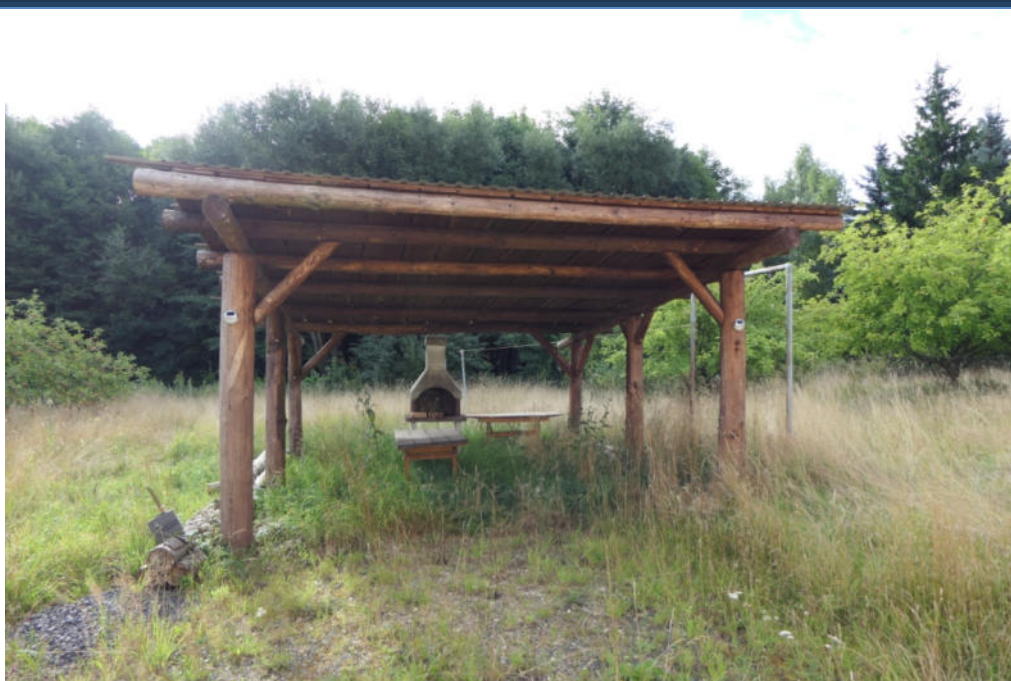
Abbildung 13: Carport aus Holz; verwilderte Außenanlagen; Blick zum östlichen Grundstücksbereich
