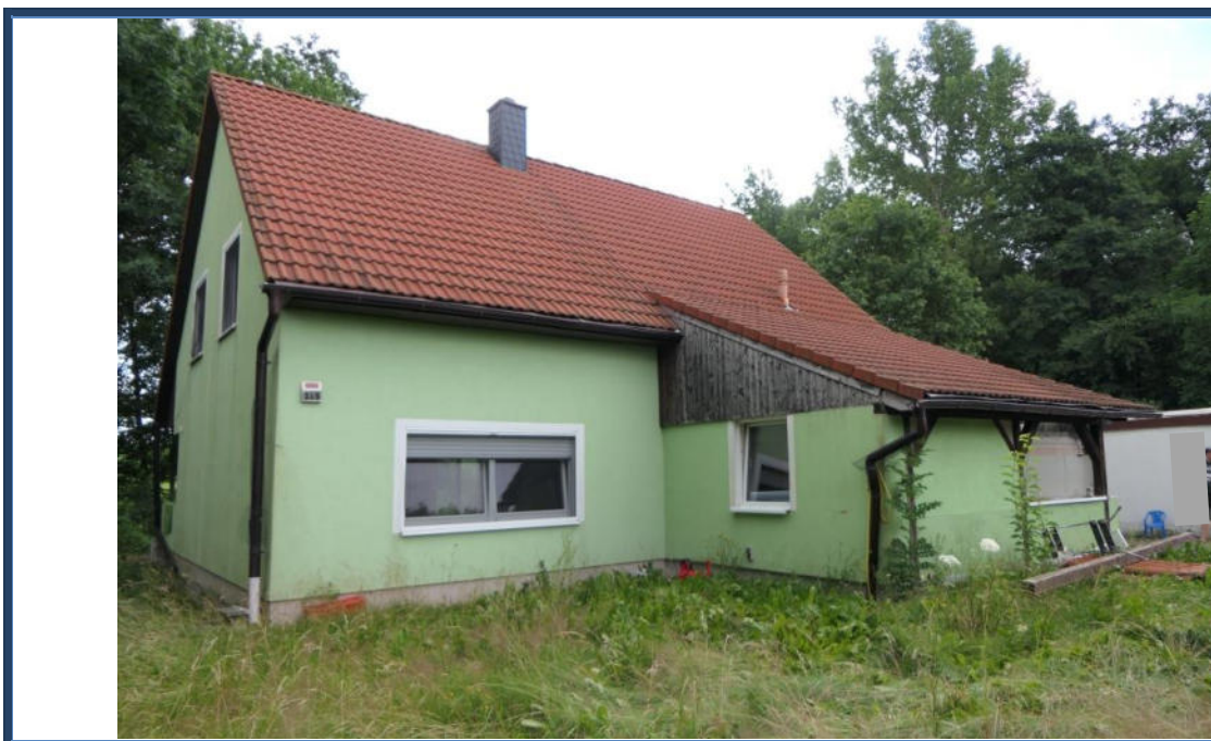
Abbildung 2: Vorder- und Giebelansicht des Einfamilienhauses (Nord-West-Ansicht); verwilderte Außenanlagen
