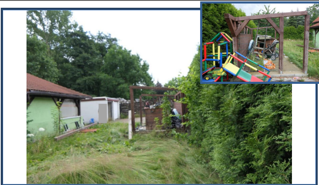
Abbildung 29: Verwilderte und beschädigte Außenanlagen im westlichen Grundstücksbereich
