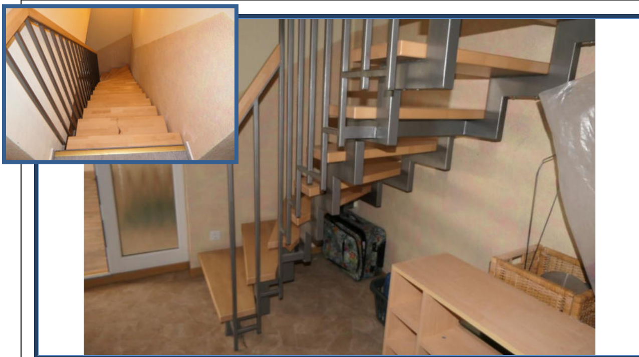
Abbildung 15: Treppe zwischen Erd- und Dachgeschoss
