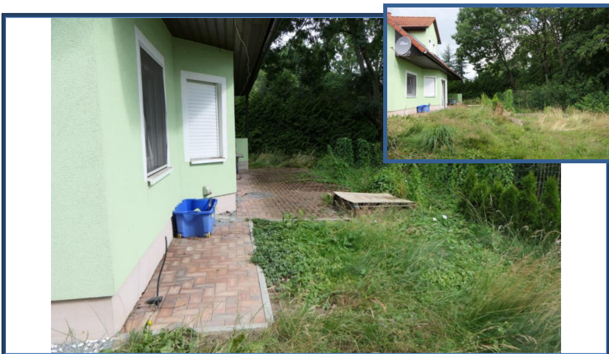
Abbildung 25: Terrasse an der Gebäudeostseite; verwilderte Außenanlagen auf Flurstück 71/2
