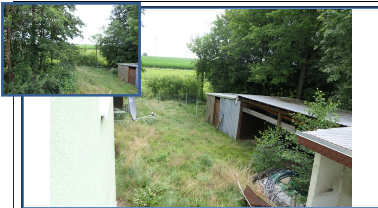
Abbildung 19: Blick vom Dachgeschoss in östliche Richtung zum Flurstück 71/2; rechts: rückseitige Anbauten an die Doppelgarage; umliegende Nutzung
