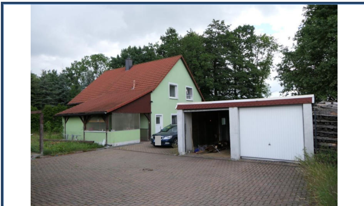
Abbildung 30: Einfahrtbereich; rechts die Doppelgarage; Außenanlagen
