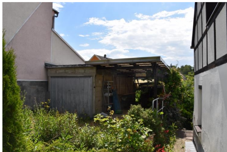
Foto 2: Giebelansicht von der Alaunstraße mit Garagenbebauung
