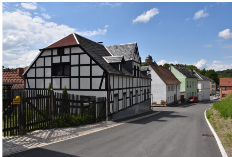
Foto 1: Südansicht von der Alaunstraße
