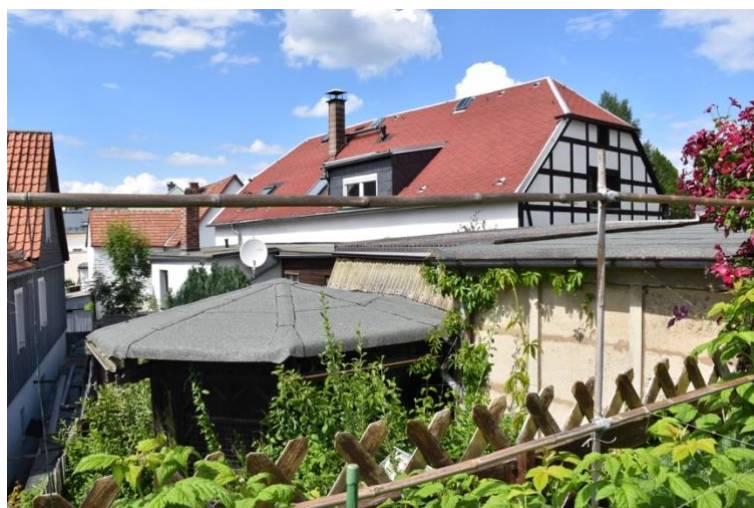
Foto 6: Ansicht vom Flurstück 227 auf den Rückraum
