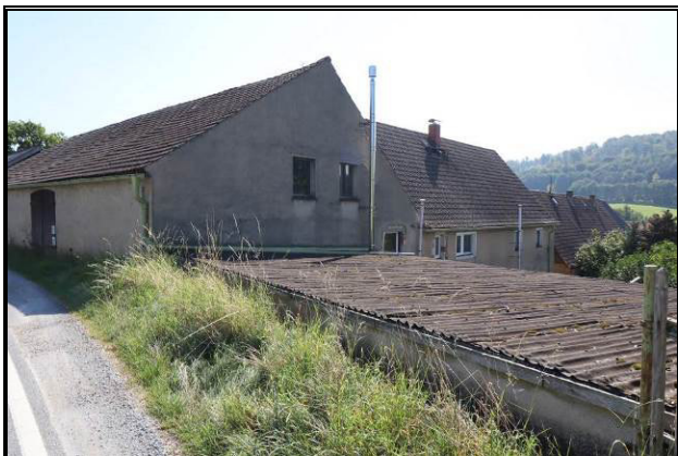
Nord-West-Ansicht des Bewertungsobjekts
