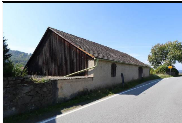
Nord-Ost-Ansicht der ehemaligen Scheune
