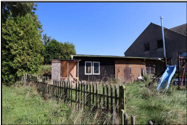
Süd-West-Ansicht des abrisssreifen Nebengebäudes
