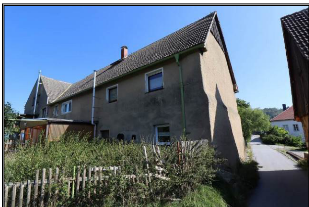
Süd-West-Ansicht des Wohnhauses
