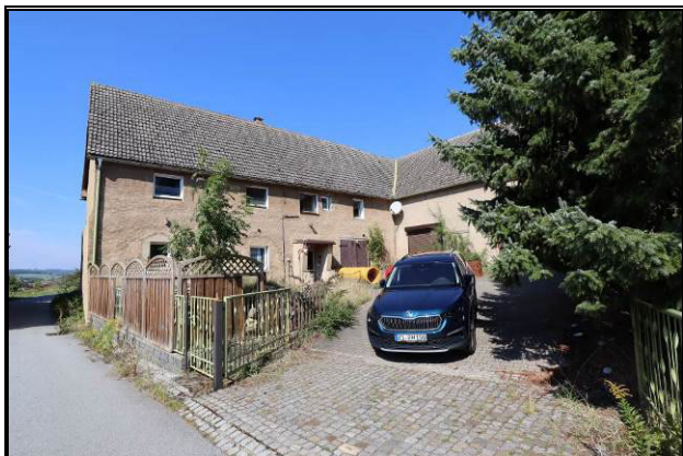
Süd-Ost-Ansicht des Bewertungsobjekts mit Grundstückszufahrt
