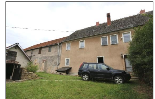
Blick auf die nordöstlich ausgerichtete Fassadenseite des Wohnhauses
