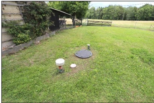
im nordöstlichen Grundstücksbereich ist die ca. 2016 erneuerte Kleinkläranlage angeordnet
