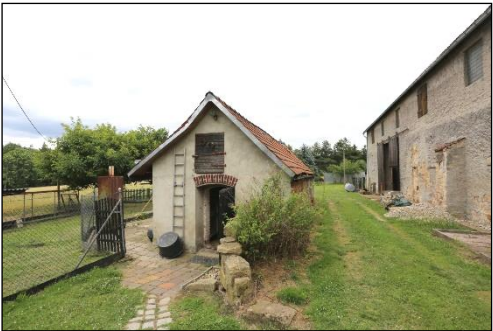
Nordöstlich des Wohnhauses ist ein massives Nebengebäude angeordnet
