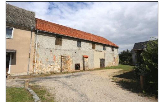
Blick auf die südwestlich ausgerichtete Fassadenseite des Scheunenanbaus
