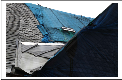
Teilansicht Dach zur R.-Koch-Straße.
