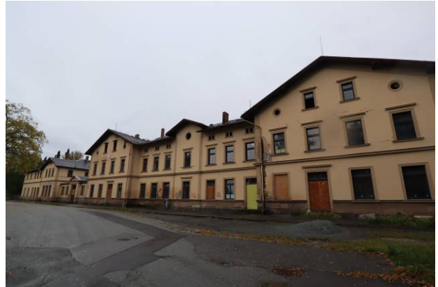
Ost-Ansicht des Bewertungsobjekts von der Bahnhofstraße
