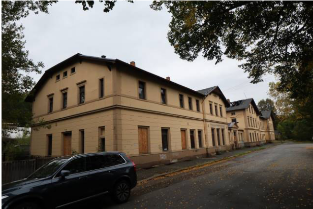
Süd-Ansicht des Bewertungsobjekts von der Bahnhofstraße
