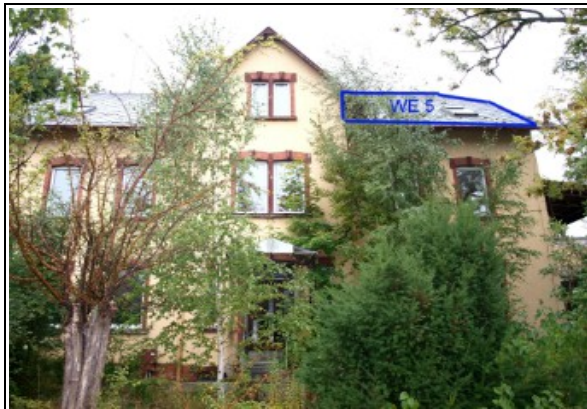
straßenseitige Ansicht mit SE-Nr. 5 im DG rechts aus Richtung Süden
