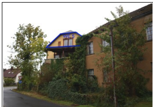
straßenseitige Ansicht mit SE-Nr. 5 aus Richtung Nordost am Turnhallenweg
