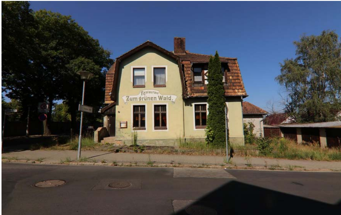
Blick in westliche Richtung auf die Seite der Mühlenstraße in Weißwasser vom Wohn- und Geschäftshaus Mühlenstraße 32.
