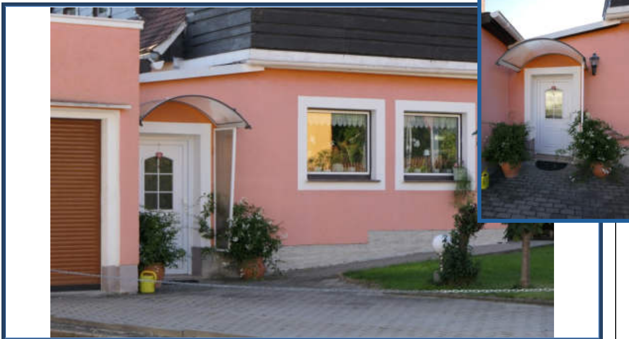
Abbildung 7: Hauseingangsbereich an der Gebäudewestseite
