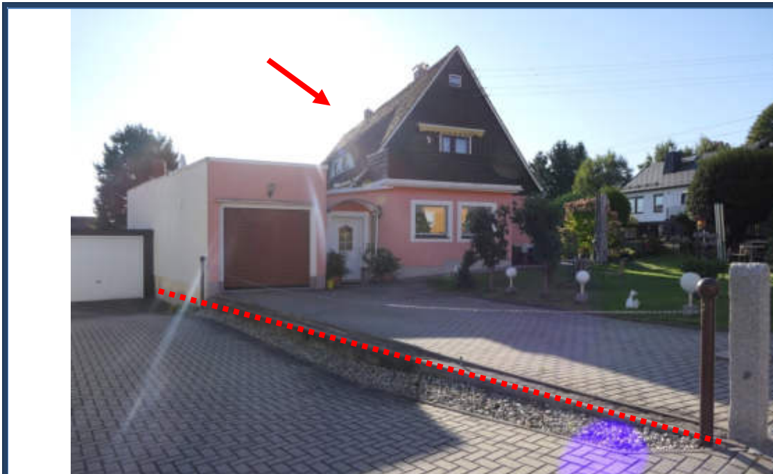
Abbildung 1: Straßenansicht von der Artur-Neumann-Straße (West-Ansicht); Außenanlagen; angrenzende und umliegende Bebauung
