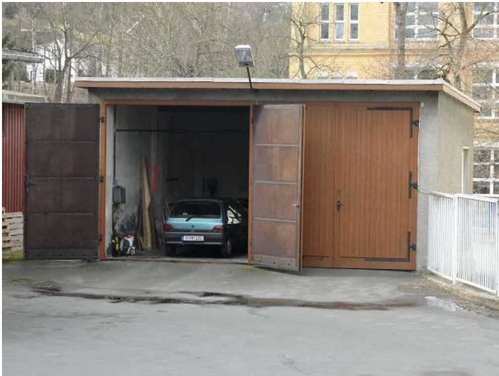
Blick auf die LKW-Garagen (Doppelgarage)
