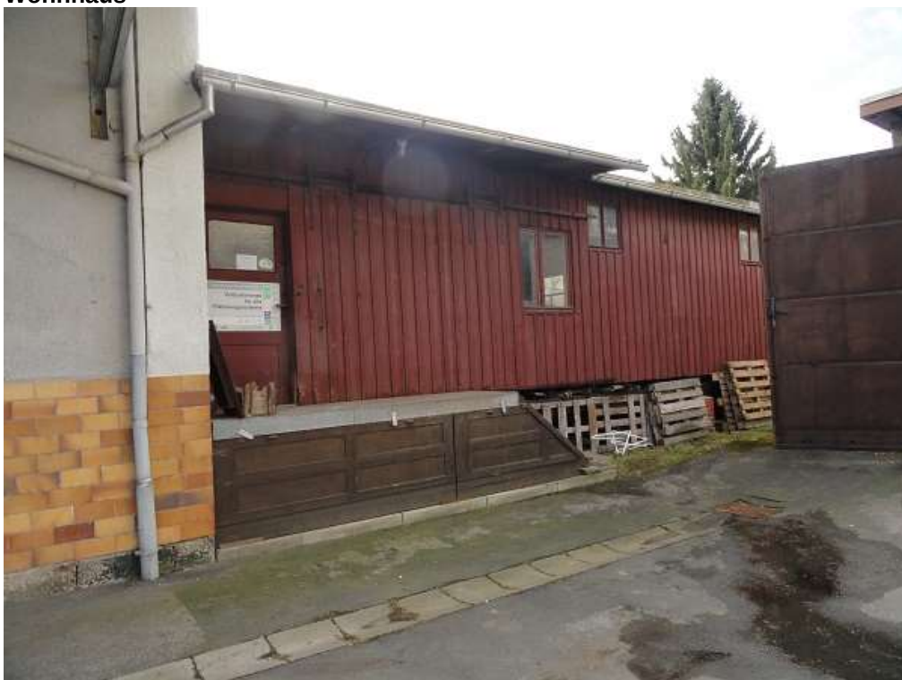
Blick auf einen Bereich des Schuppenanbaus (an das Mühlengebäude angebaut)
