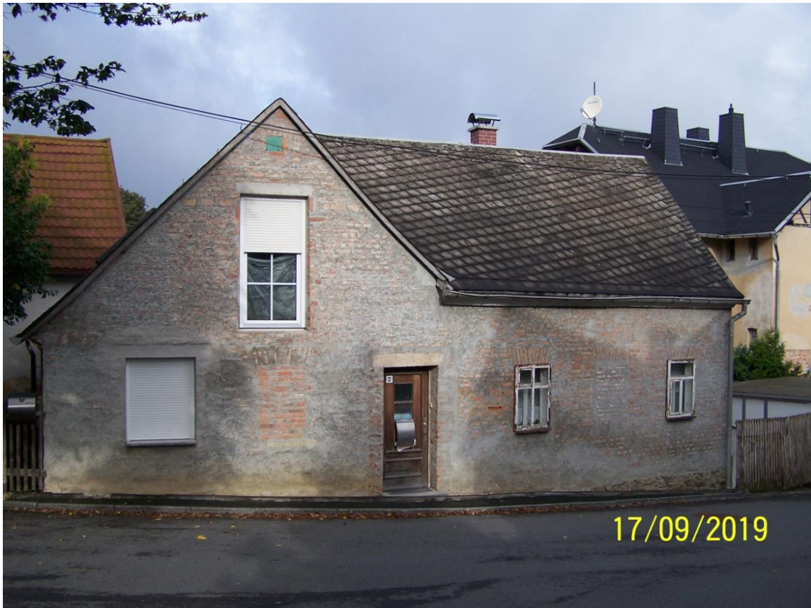
3K 265/18 Straßenansicht Wilkau-Haßlau OT Culitzsch, Kirchgasse 2
