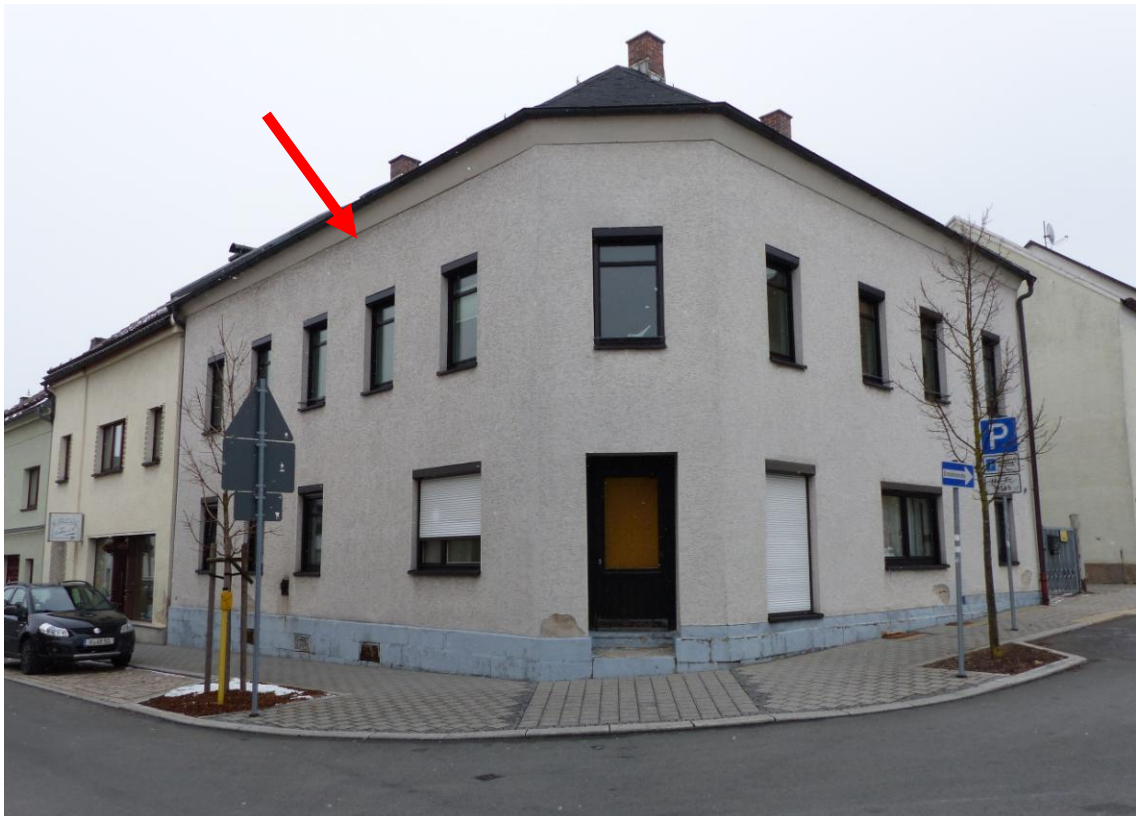
Süd-West-Ansicht von der Kreuzung „Gartenstraße / August-Bebel-Straße“
