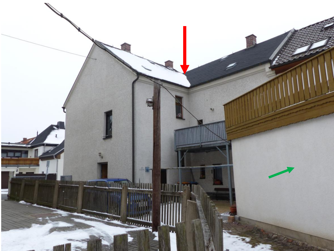
Ansicht vom Lagerschuppen zur Hofseite des Wohnhauses (rot) und Nachbargebäude (grün)
