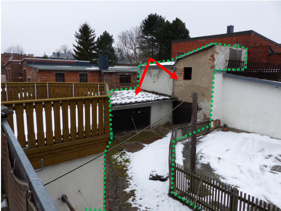
Ansicht vom Wohnhaus zum Lagerschuppen (rot) und Flurstücksgrenze (grün)
