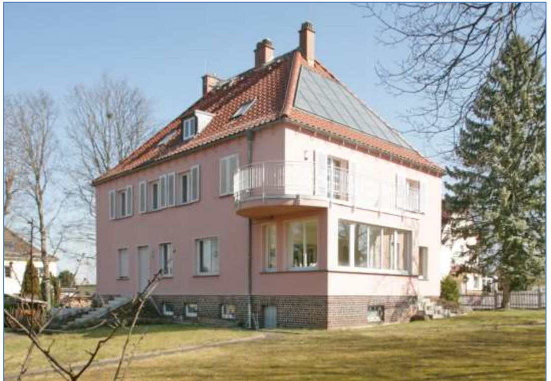
Bild 3 Wohnhaus, Gartenansicht von Südwest
