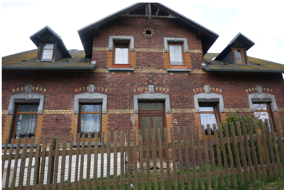
Ansicht vom EFH mit Hauseingang in das Erdgeschoss (EG)
