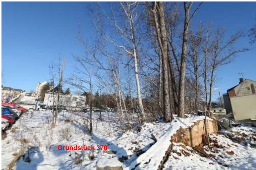
Foto 4: Grundstück 370 mit Fundamentresten und Bewuchs
