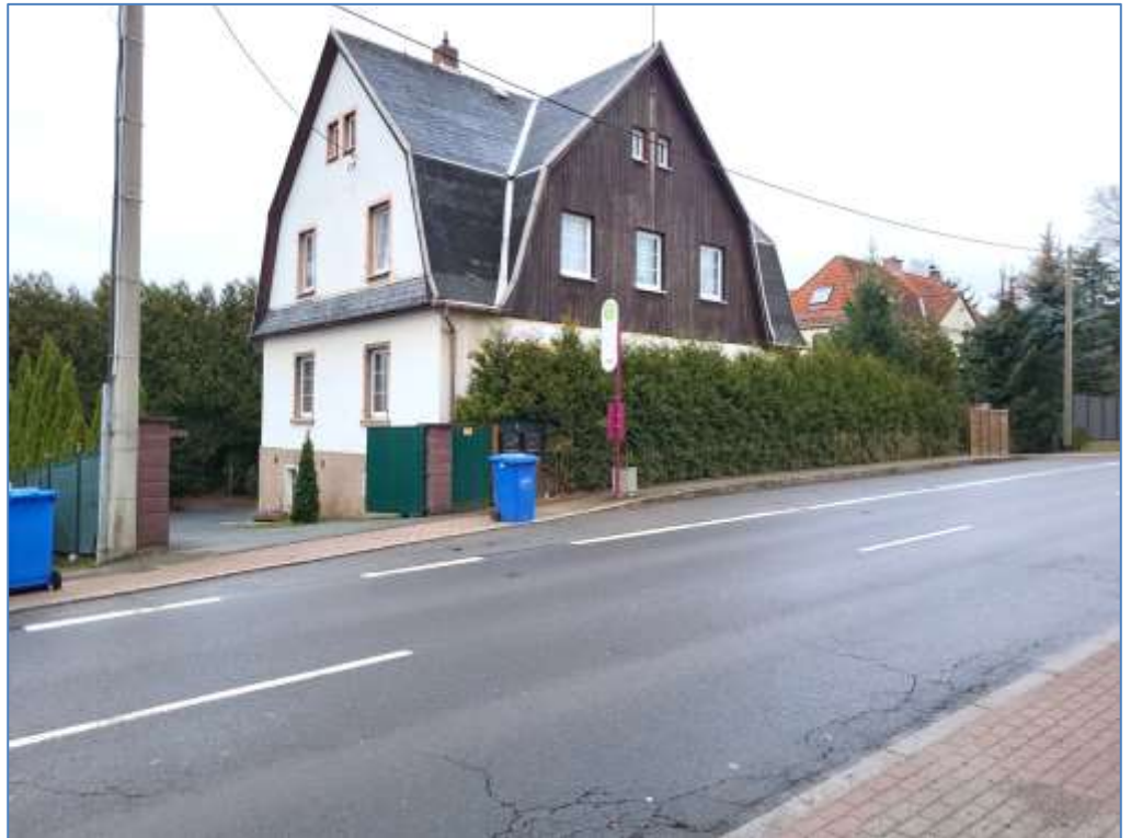
Bild 1 Wohnhaus, Straßenansicht von Nordost
