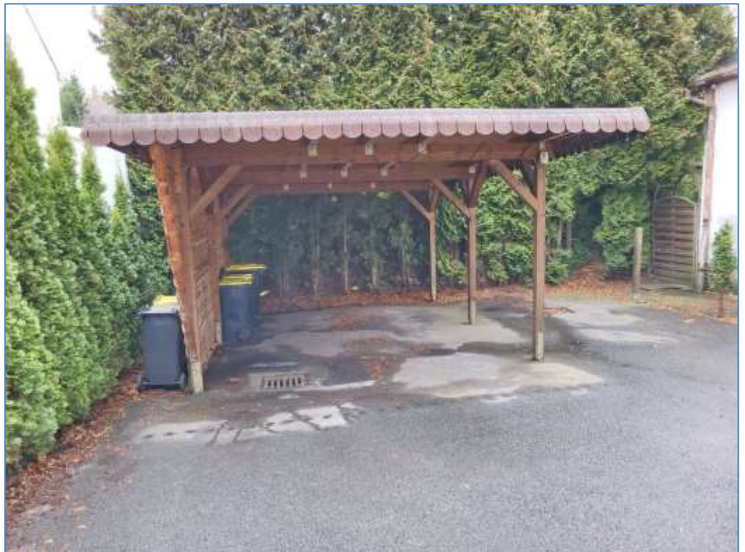
Bild 8 Carport im Hofraum
