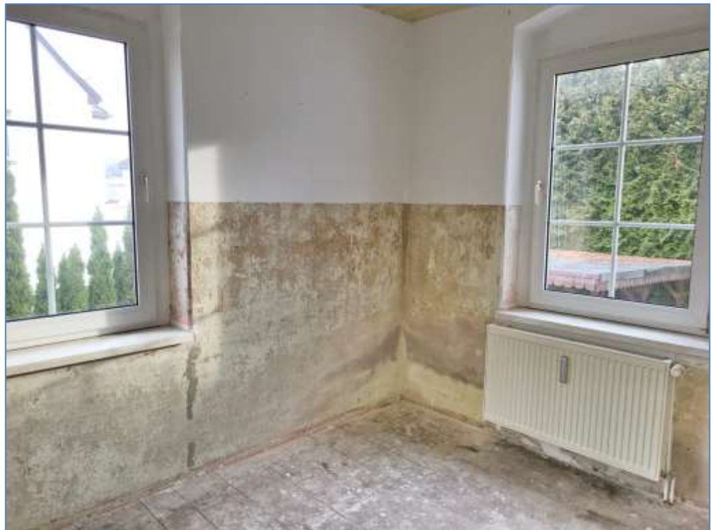
Bild 16 WC der Wohnung im Erdgeschoss
