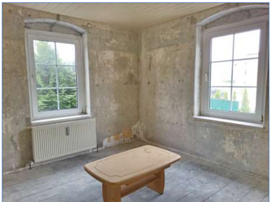
Bild 14 Raum der Wohnung im Erdgeschoss
