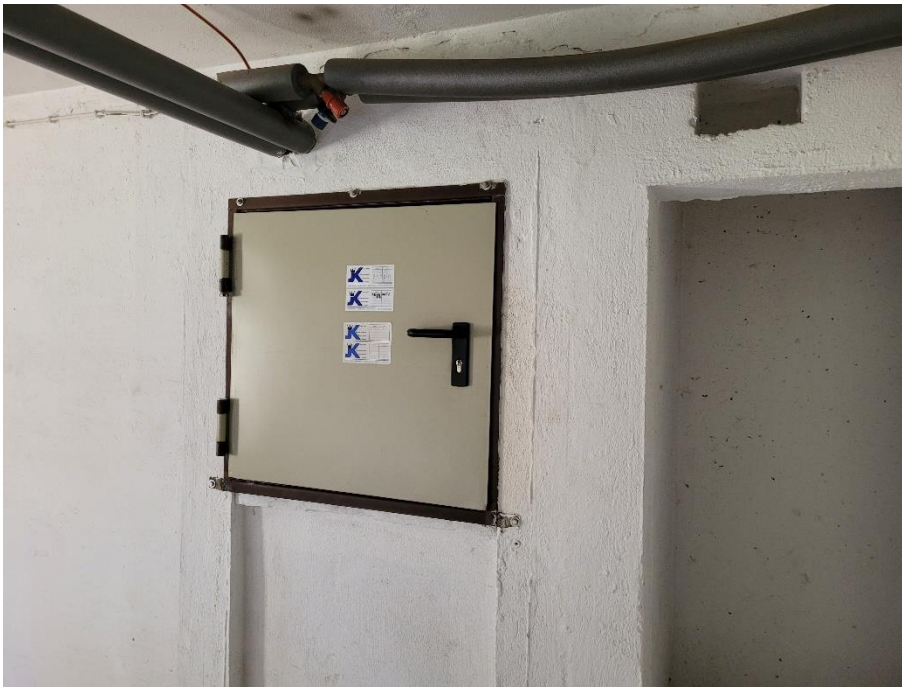
Luke/Tür zum Heizungsraum
