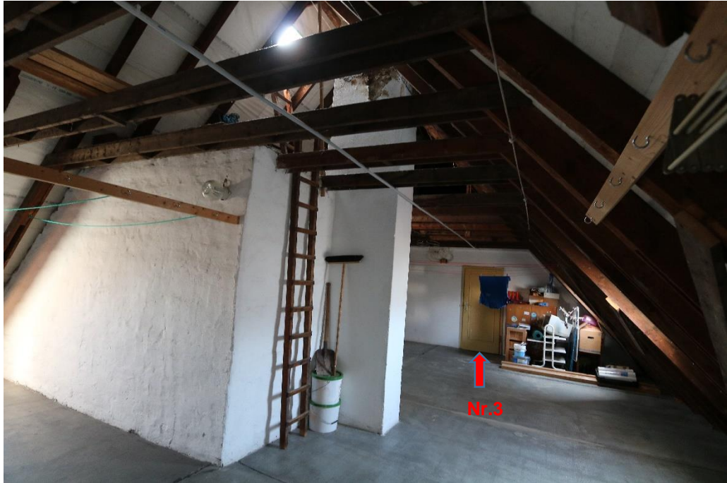
Foto 10: DG, Dachkammer Nr.3
