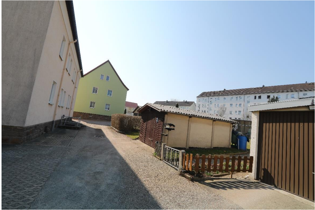
Foto 5: Hofseite mit Nebengebäuden (SNR) nach Süd
