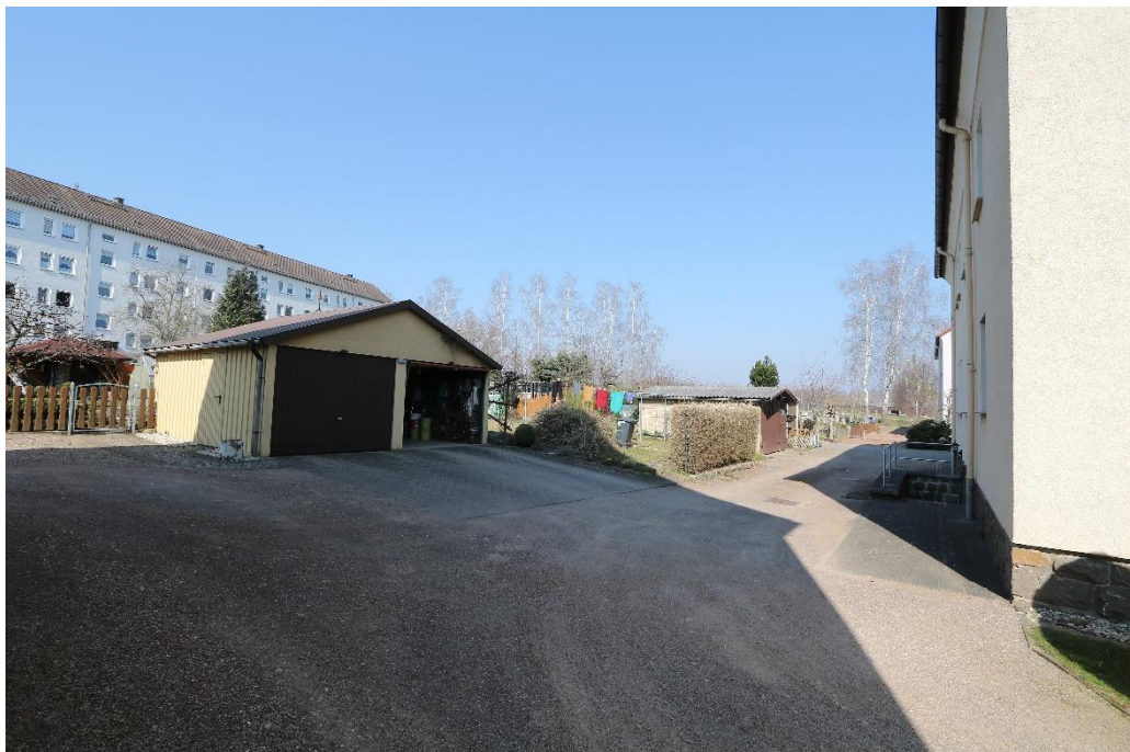
Foto 6: Hofseite mit Nebengebäuden (SNR) nach Nord
