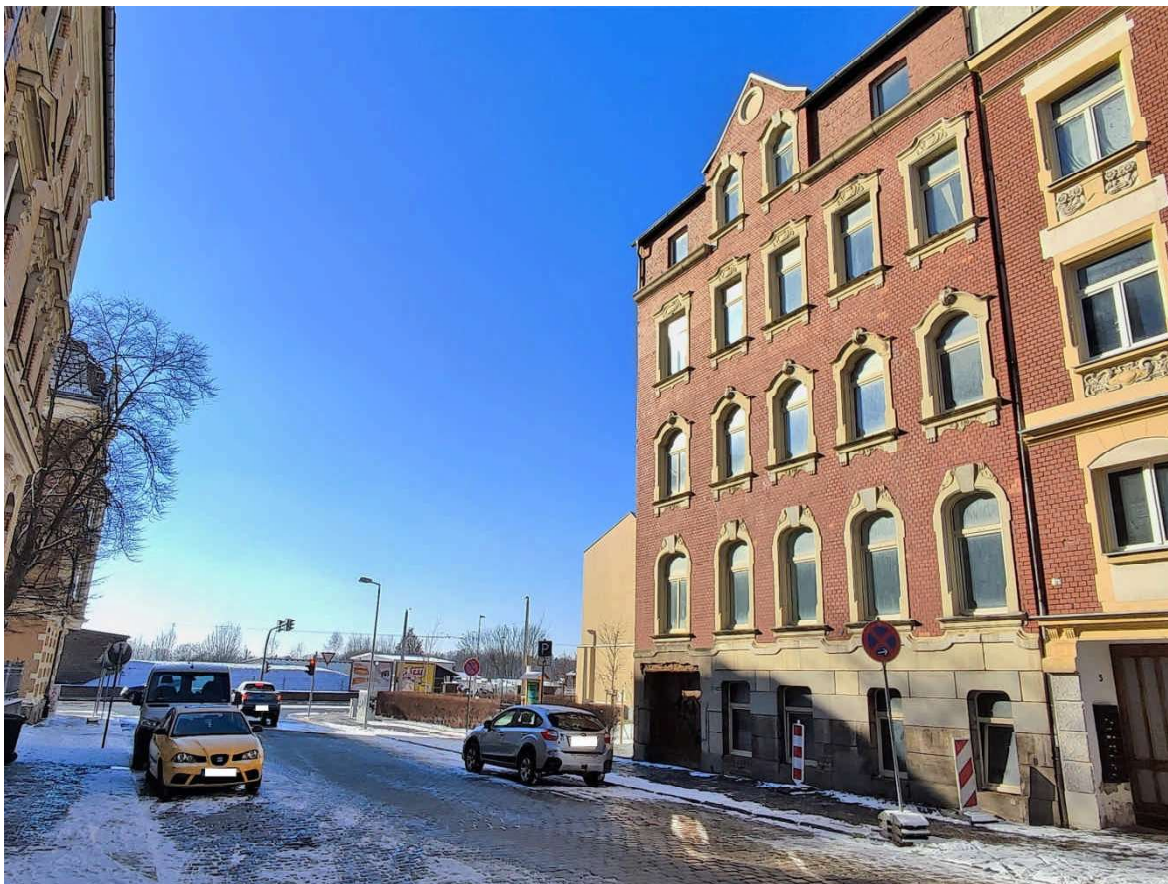
Plauen, Rückertstraße 3, Gesamtansicht
