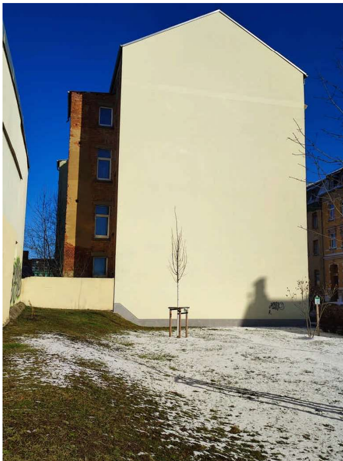
Wohnhaus auf Flurstück 486, SW-Ansicht
