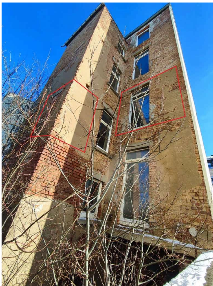
Wohnhaus mit WE Nr. 4 und zugehörigem Abstellraum im Treppenhaus (rot umrandet), Nordansicht
