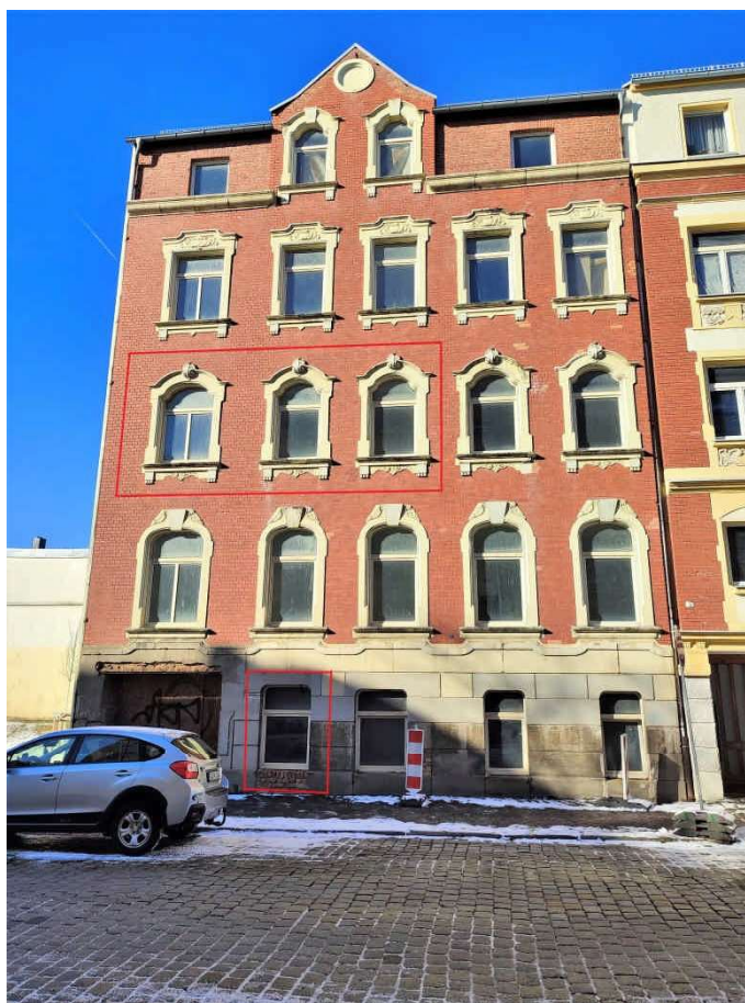
Rückertstraße 3, Wohnhaus mit WE Nr. 4 im I.OG und Keller Nr. 4 im Souterrain (rot umrandet), SO-Ansicht
