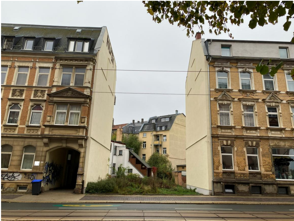
Bild 7, Blick von der Pausaer Straße auf das freigelegte Grundstück Flurstück 644
