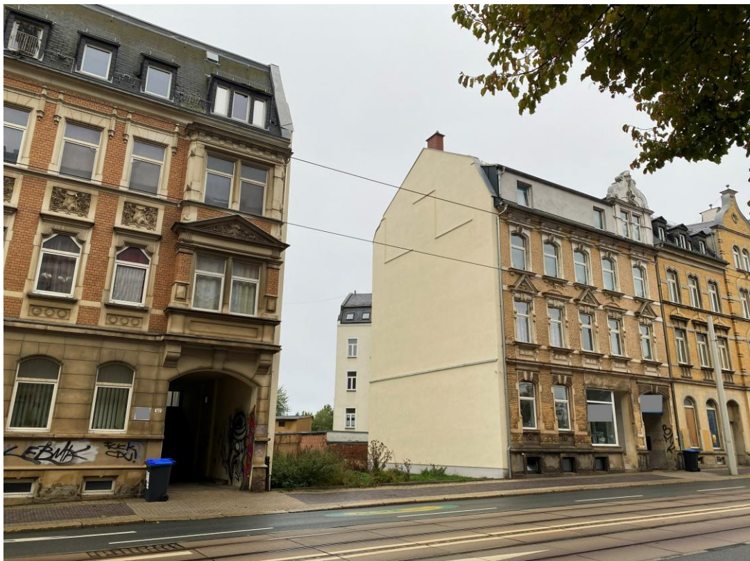
Bild 6, Ansicht des nördlichen Giebels vom Gebäude Pausaer Straße 111
