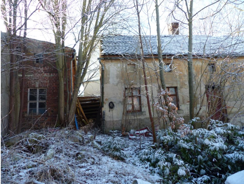
Nord-Ansicht zum Wohnhaus und Nebengebäude (links)
