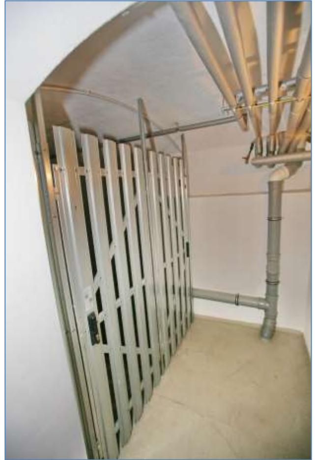
#Bild 6 Kellergeschoss mit Kellerraum der Wohnung Nr. 1
