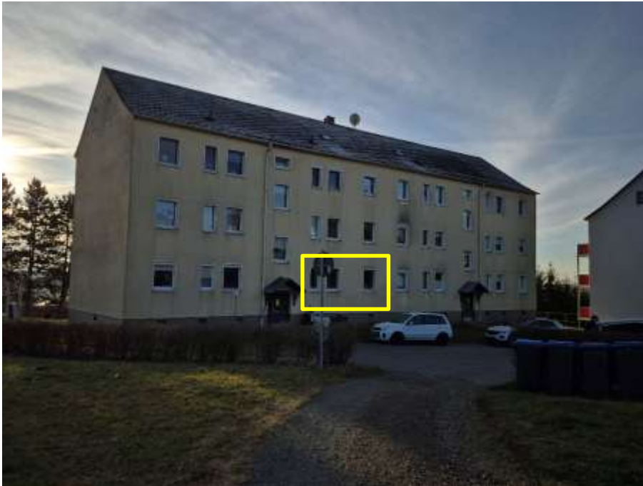
Blick auf den Wohnblock mit Kennzeichnung der Lage des Bewertungsobjekts
