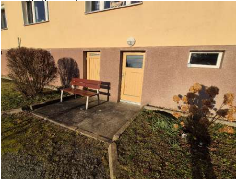
Türen zum Garten mit dem Wäscheplatz auf der gartenseitig orientierten Gebäudelängsseite
