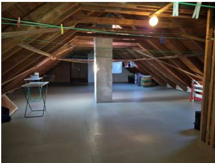
Blick in den Dachboden (Wäscheboden)
