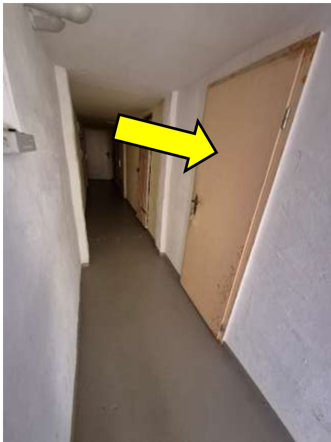
Kellergang mit Blick auf die Tür zu einem Kellerabstellraum, der dem Wohnungseigentum zugeordnet ist
