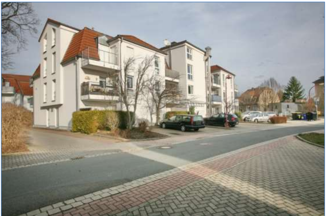
Bild 2 Wohnpark Postweg, Gebäude III, Straßenansicht von Südwest
