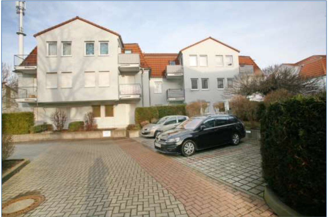
Bild 5 Wohnpark Postweg, Gebäude I, Ansicht von Süd
