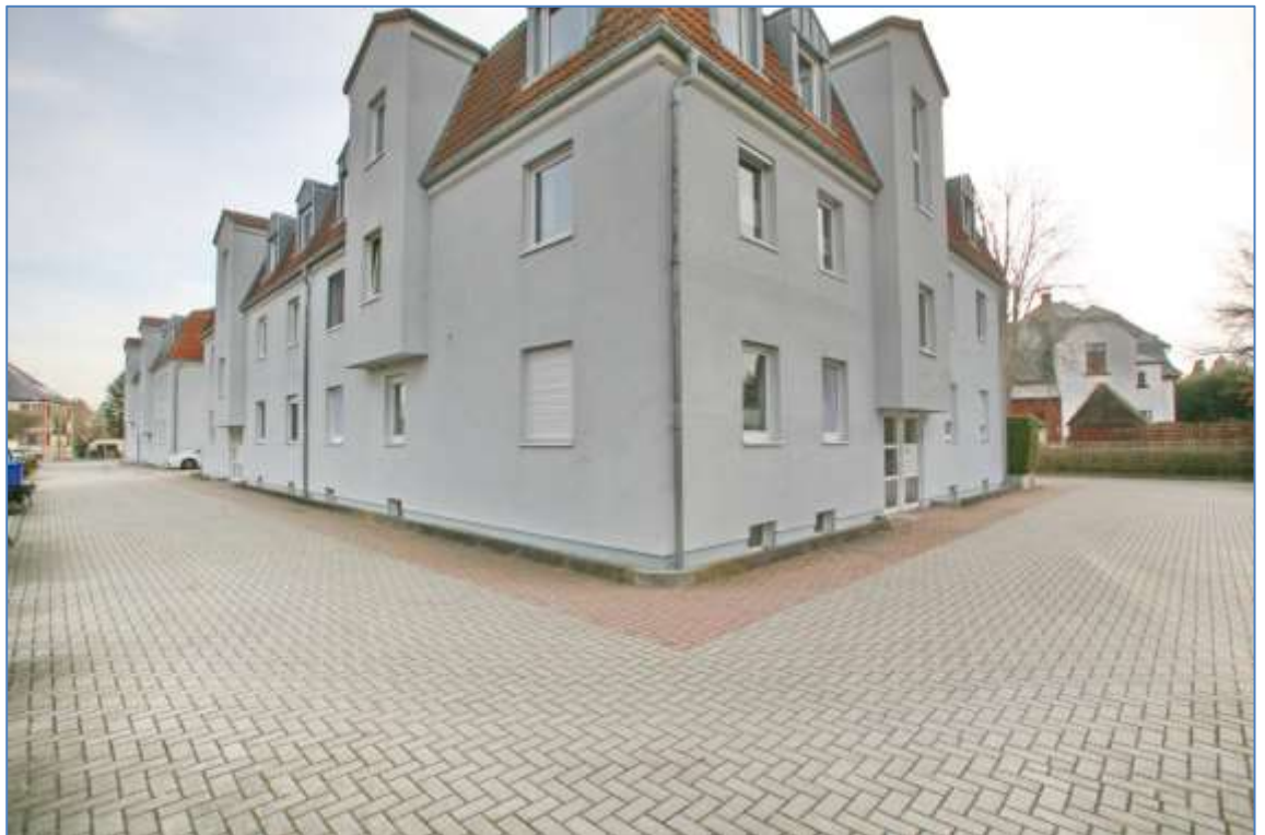
Bild 6 Wohnpark Postweg, Gebäude I und II, Ansicht von Nordwest
