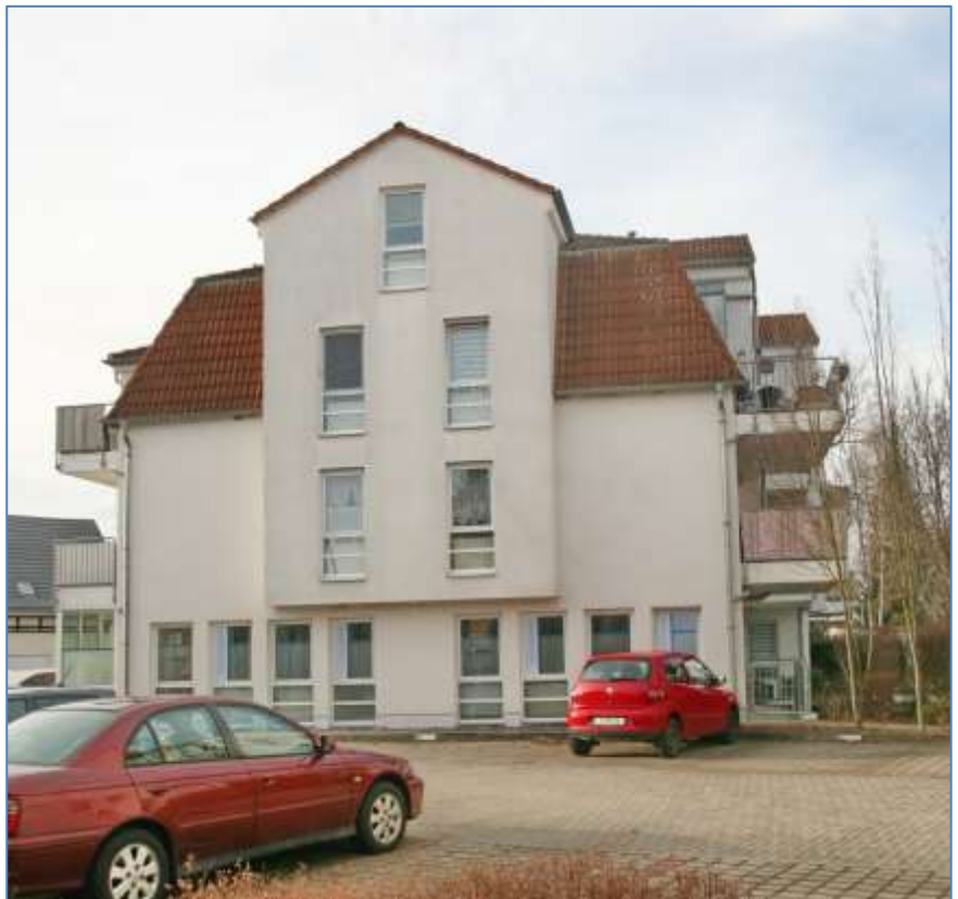
Bild 8 Wohnpark Postweg, Gebäude III, Straßenansicht von Ost
