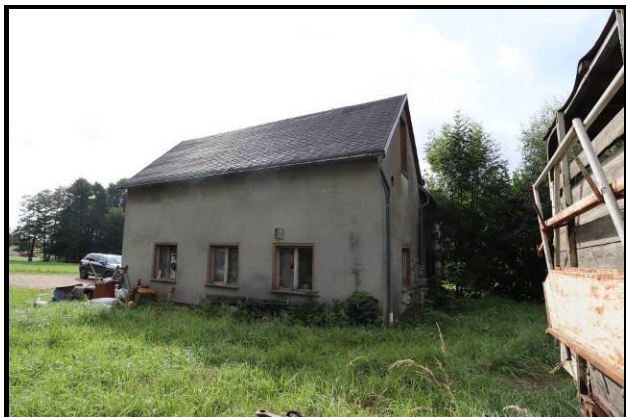
Nord-Ansicht des Mehrzweckgebäudes
