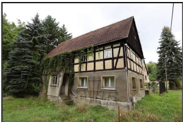
Süd-Ost-Ansicht des denkmalgeschützten Fachwerkhouses
