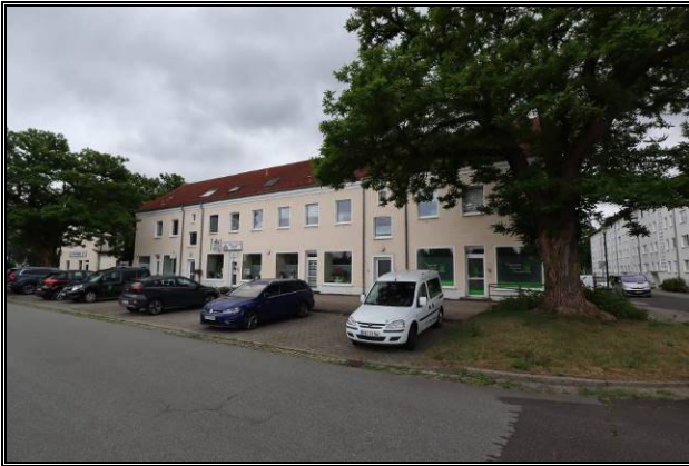
Nord-Ansicht des Gebäudes August-Bebel-Straße 5, 5a und 6
