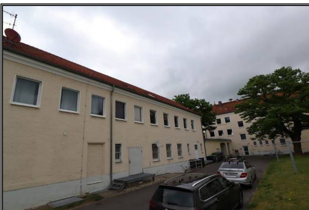
West-Ansicht mit Teil der Außenanlagen
