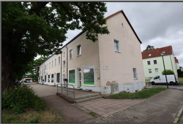
Nord-West-Ansicht des Gebäudes August-Bebel- Straße 5, 5a und 6
