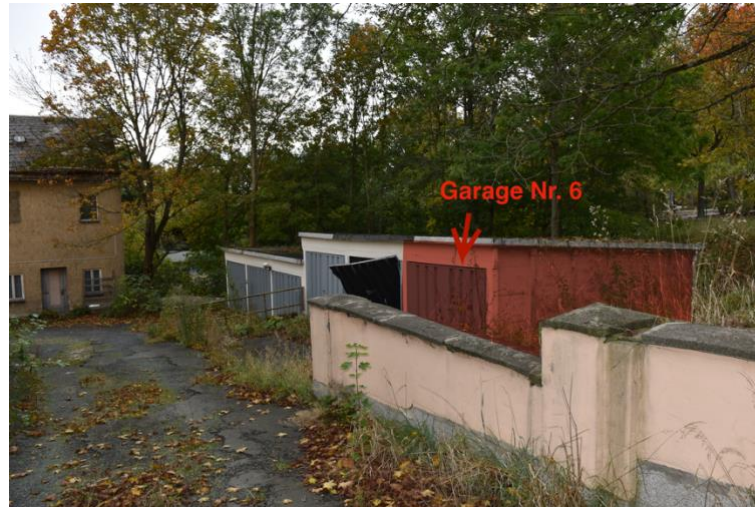
Foto 1: Nordostansicht vom Flst.: 482 auf das Flst.: 483/3 mit Markierung der Garage Nr. 6
