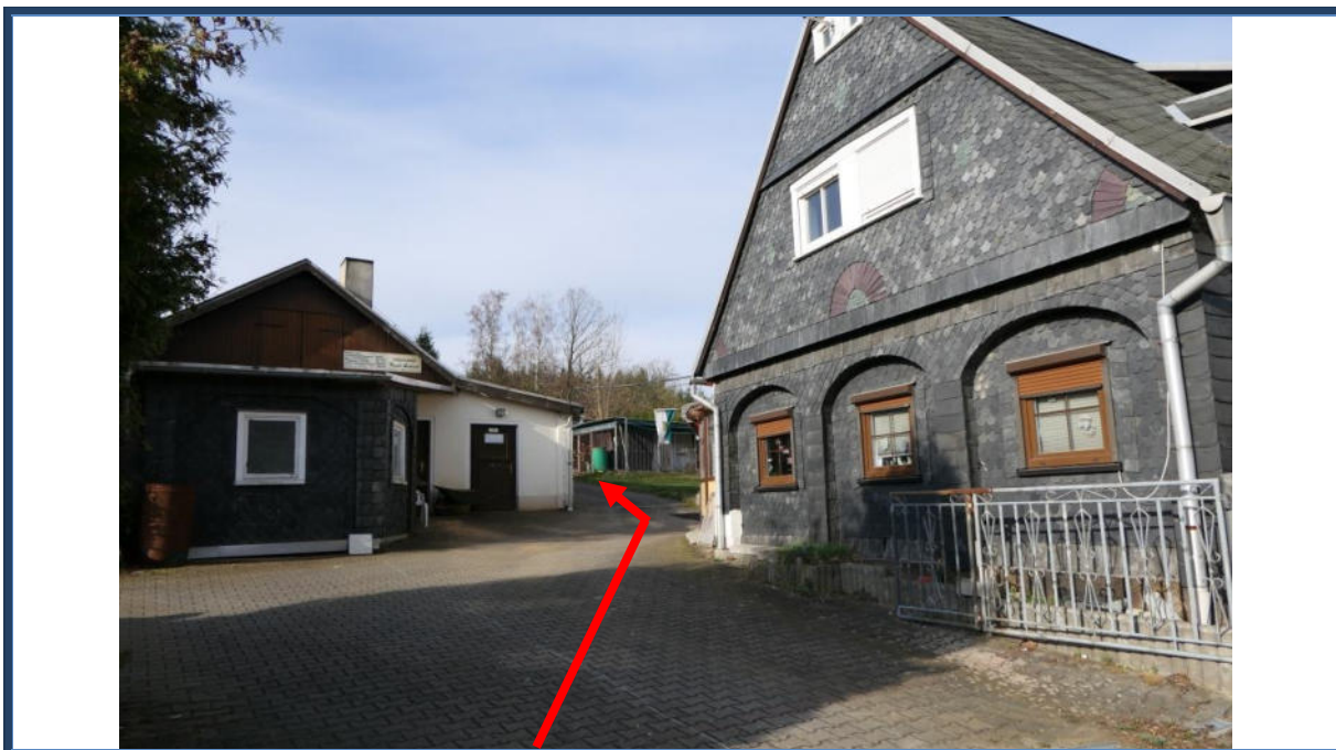
Abbildung 16: Blick in westliche Richtung (Grundstückszufahrt über das benachbarte Flurstück 609; kein dinglich gesichertes Wegerecht); umliegende Bebauung
