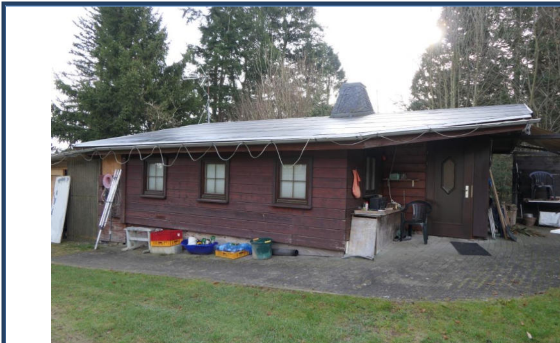
Abbildung 1: West-Ansicht des Gartenhauses; rechts der Eingangsbereich; Außenanlagen
