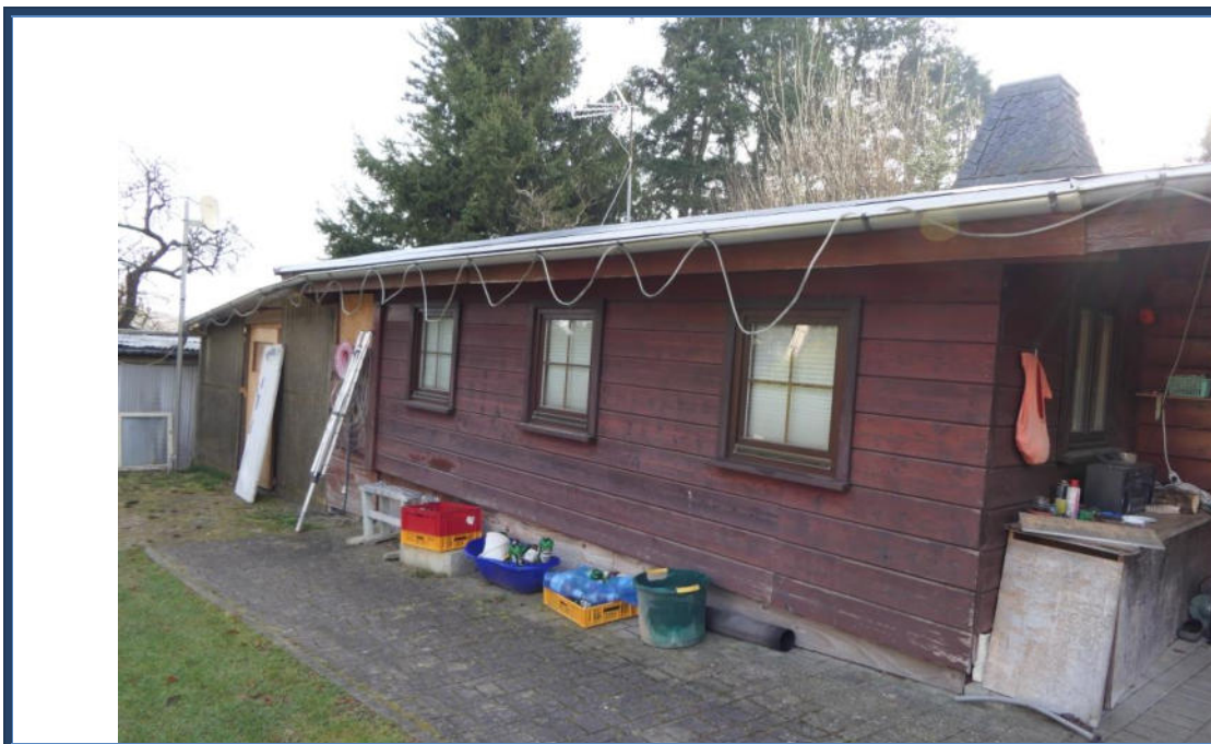
Abbildung 2: West-Ansicht des Gartenhauses; links der angebaute Schuppen; Außenanlagen
