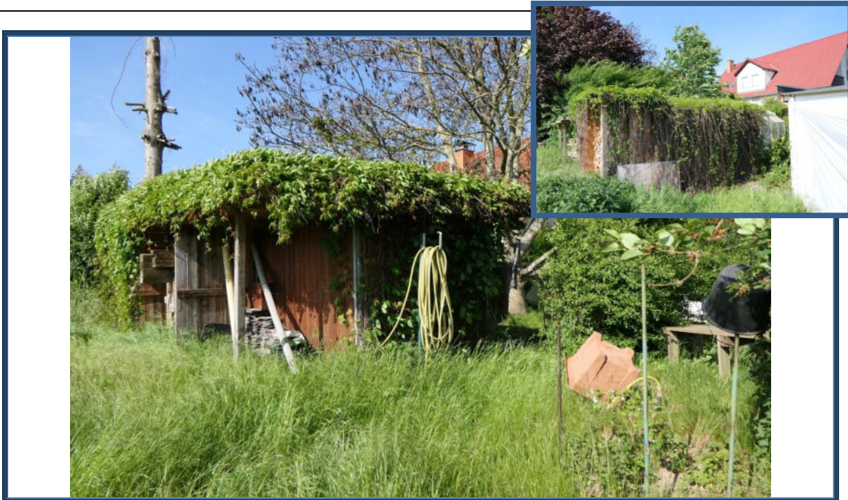
Abbildung 13: Einfache Nebengebäude (Holzunterstände o. ä.) im westlichen Grundstücksbereich
