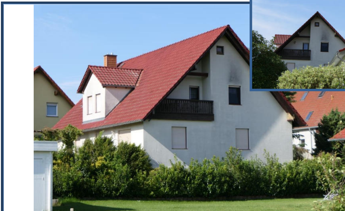
Abbildung 5: Rück-Giebelansicht (Nord-Ost-Ansicht); Außenanlagen; umliegende Bebauung
