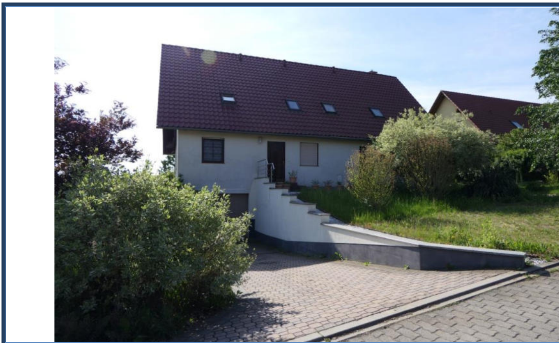
Abbildung 3: Straßenansicht (West-Ansicht); Eingangs-/Einfahrtsbereich; links die Garagenzufahrt; Außenanlagen tlw. auf dem vorgelagerten Fremdgrundstück (Flurstück 51/13); umliegende Bebauung
