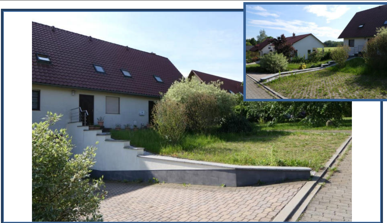
Abbildung 15: Außenanlagen im westlichen Grundstücksbereich
