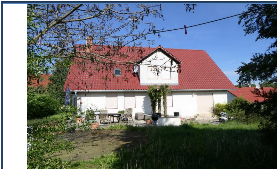
Abbildung 6: Rückansicht (West-Ansicht); Außenanlagen im westlichen Grundstücksbereich; umliegende Bebauung
