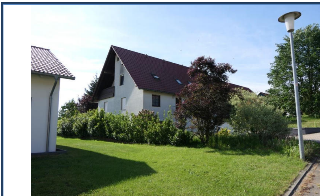
Abbildung 4: Straßen-Giebelansicht (Nord-West-Ansicht); Außenanlagen; umliegende Bebauung
