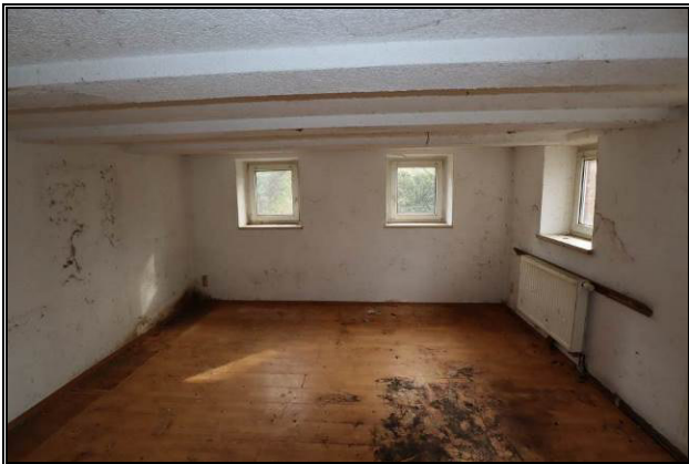
Wohnzimmer im Erdgeschoss
