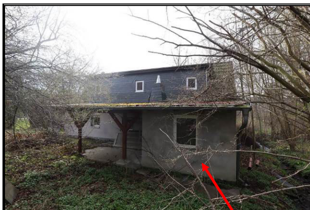
Nord-Ansicht des Bewertungsobjekts; Anbau aus 2004
