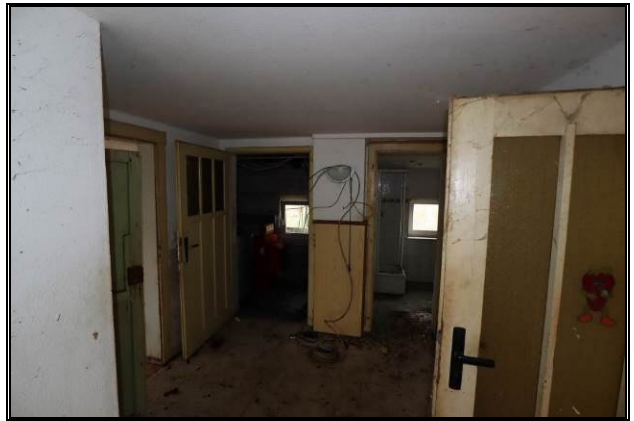
Hausflur im Erdgeschoss
