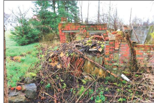
Blick auf den restlichen Baukörper und einige davor abgelagerte Materialien
