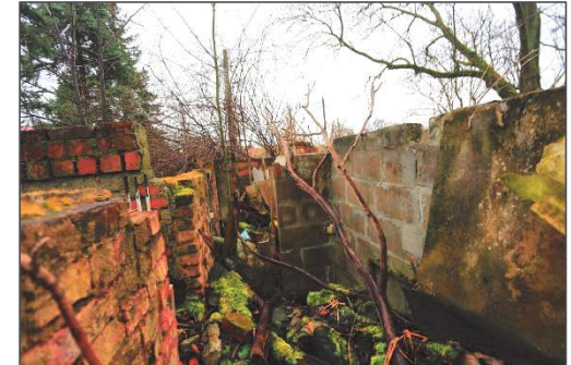
Blick in einen ehemaligen Raum. Zur Ortsbesichtigung standen noch einige Wände des Erdgeschosses
