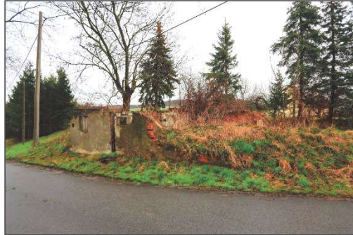
Blick auf den mittleren Gebäudeteil mit den Gebäuderesten des ehemaligen Wohngebäudes
