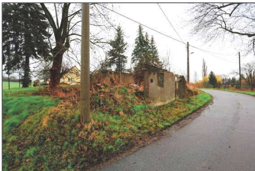
Blick auf den nördlichen Grundstückteil
