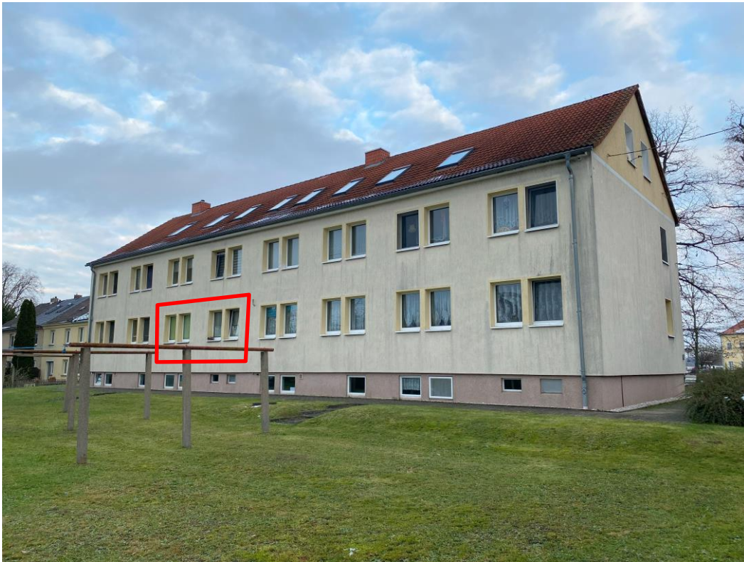
Bild 5, Ansicht der Gebäuderückseite von Süd-Westen
