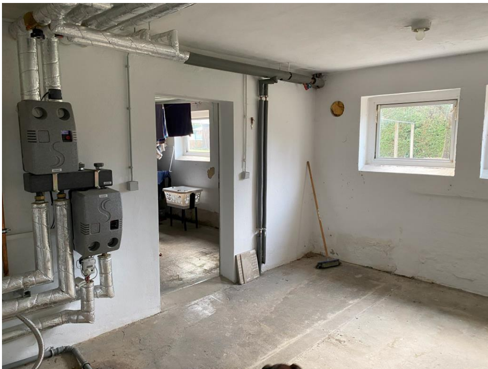
Bild 23, Blick vom Heizungsraum in den Trockenraum
