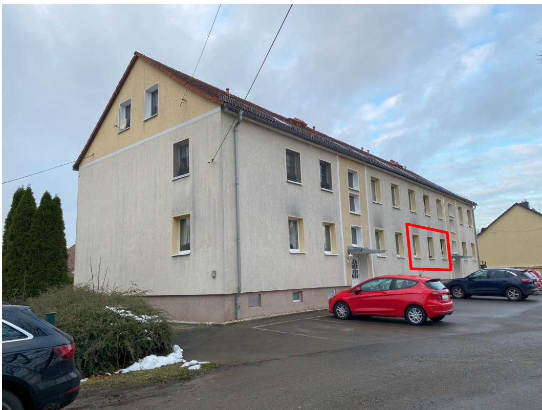
Bild 4, Ansicht von Süd-Osten mit Kennzeichnung der Lage der Wohnung Nr. 1 im Haus Nr. 10
