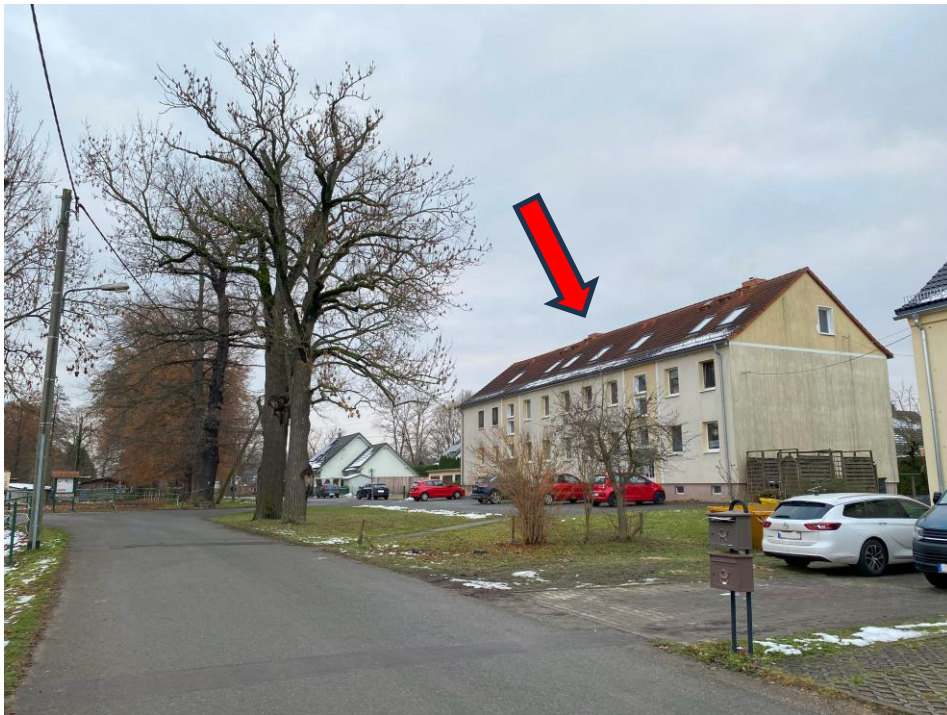
Bild 1, Alter Teichweg, Blick in Richtung Süden mit Kennzeichnung der Lage des Bewertungsgrundstücks
