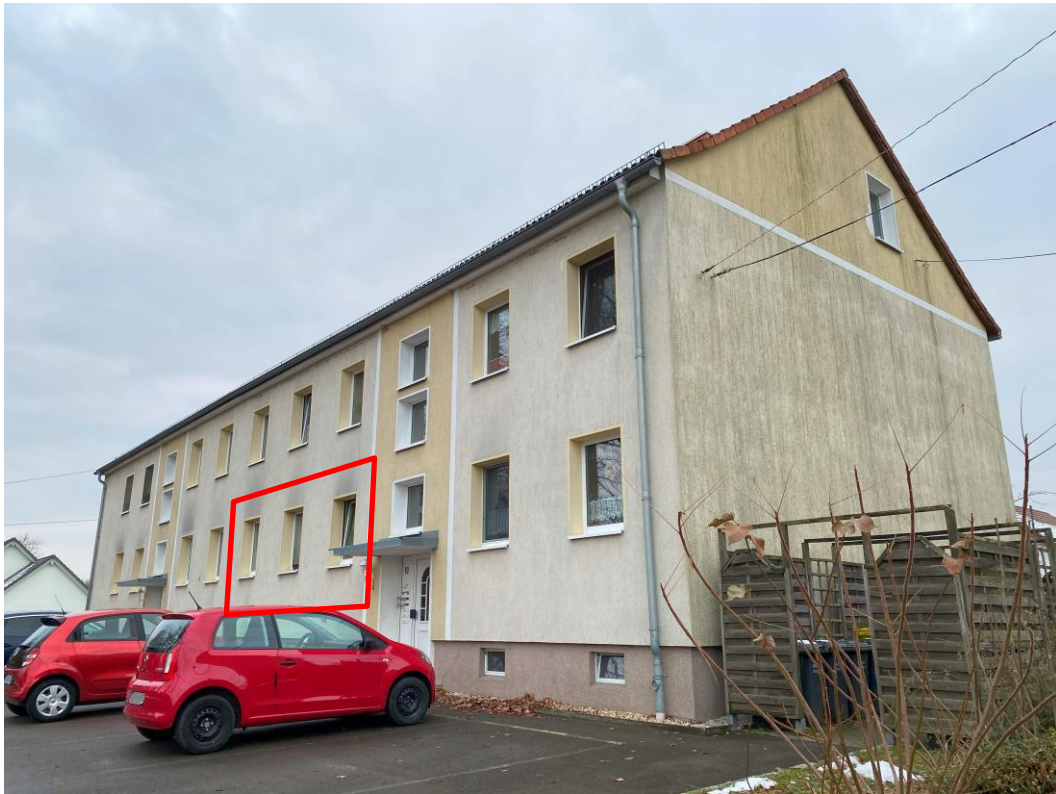
Bild 3, Ansicht der Mehrfamilienhaus-Wohnanlage Alter Teichweg 10 und 12 von Nord-Osten mit Kennzeichnung der Lage der Wohnung Nr. 1 im Haus Nr. 10
