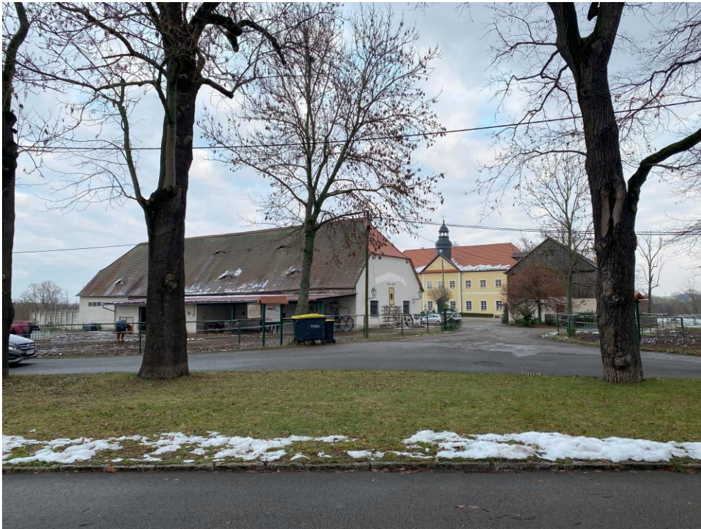
Bild 9, Blick vom Bewertungsgrundstück auf das unmittelbar gegenüber liegende Rittergut
