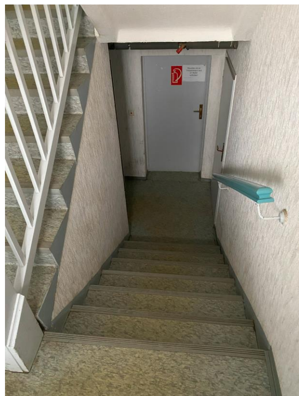
Bild 17, Treppe zum Keller
