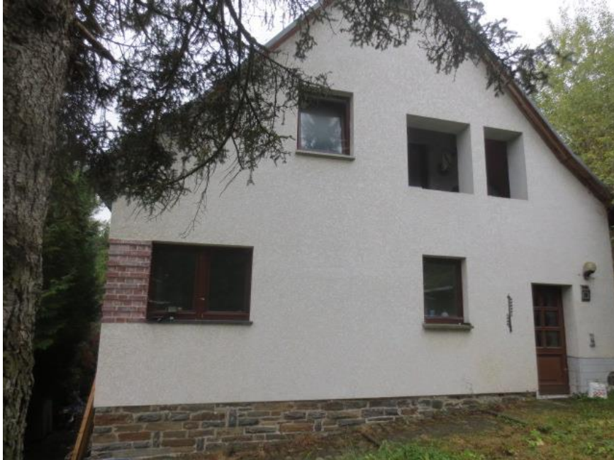
nördliche Giebelseite mit Hauseingang
